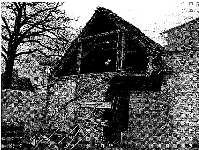
Ein kleiner Aufschiebling bedeckte den Fußpunkt der Verbindung. Die Deckenbalken (zwischen 25/30 und 23/28 cm im Querschnitt) überspannten beide Außenwände und waren nur durch die Trennwand zwischen Webstube und Kammer gestützt. Ihre Stirnseiten wurden von einem durchgehenden profilierten Gesimsbalken aus Holz zu beiden Fassaden verdeckt, wobei das straßenseitige Gesims immer aufwendiger profiliert war. Der Krüppelwalm erhielt gleichfalls einen Traufbalken als Rundholzbohle.
