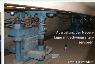
Ausrüstung der Nebenerlager mit Schwingensaitensensoren
