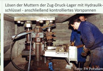
Lösen der Muttern der Zug-Druck-Lager mit Hydraulikschlüssel - anschließend kontrolliertes Vorspannen
