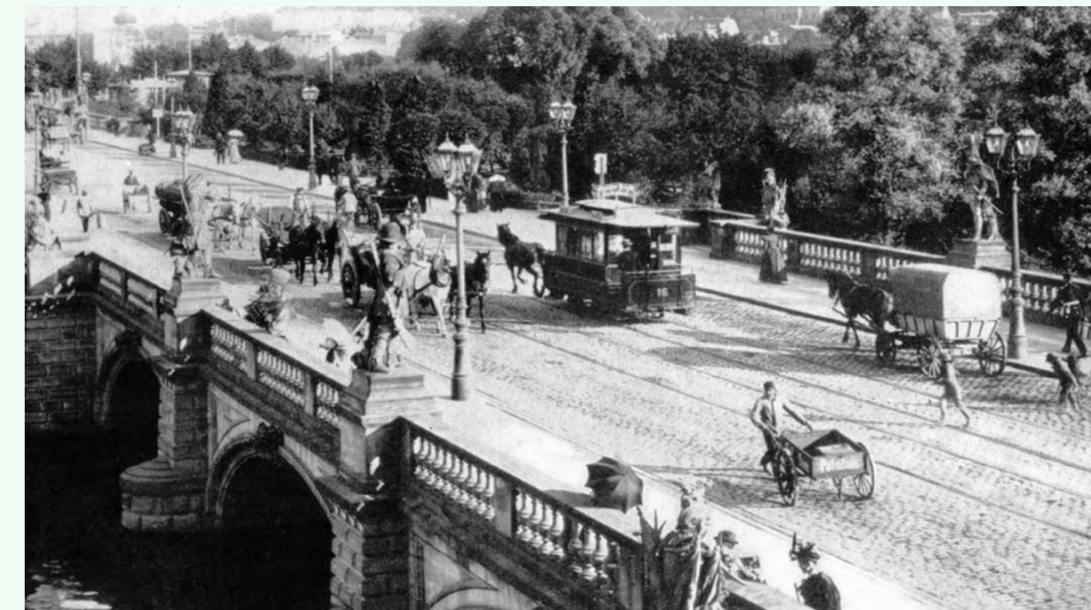
Blick auf die Lange Brücke, Alte Fahrt, 1896
