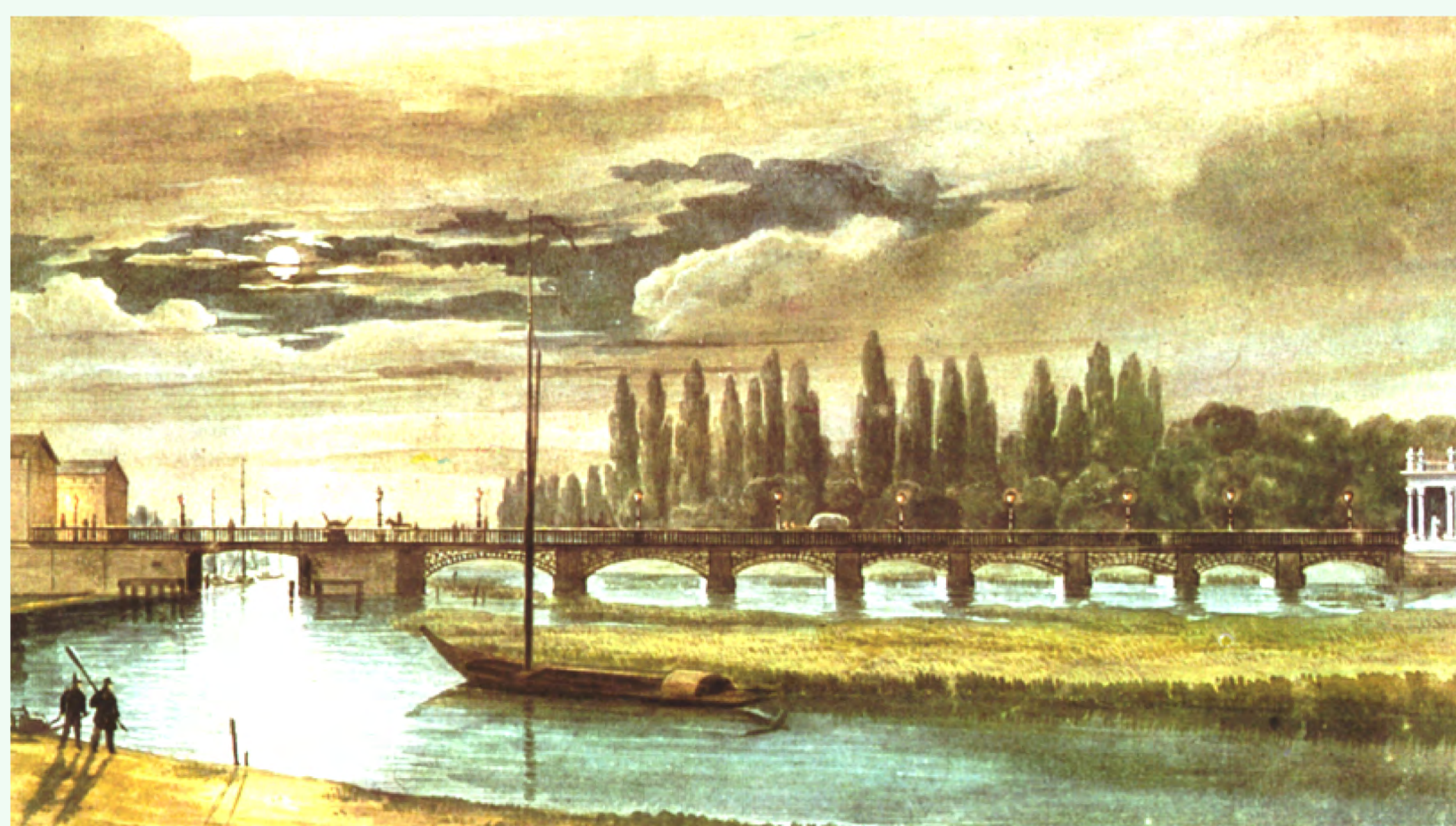
Blick auf die Gusseisenbrücke von Oberstrom, um 1840
