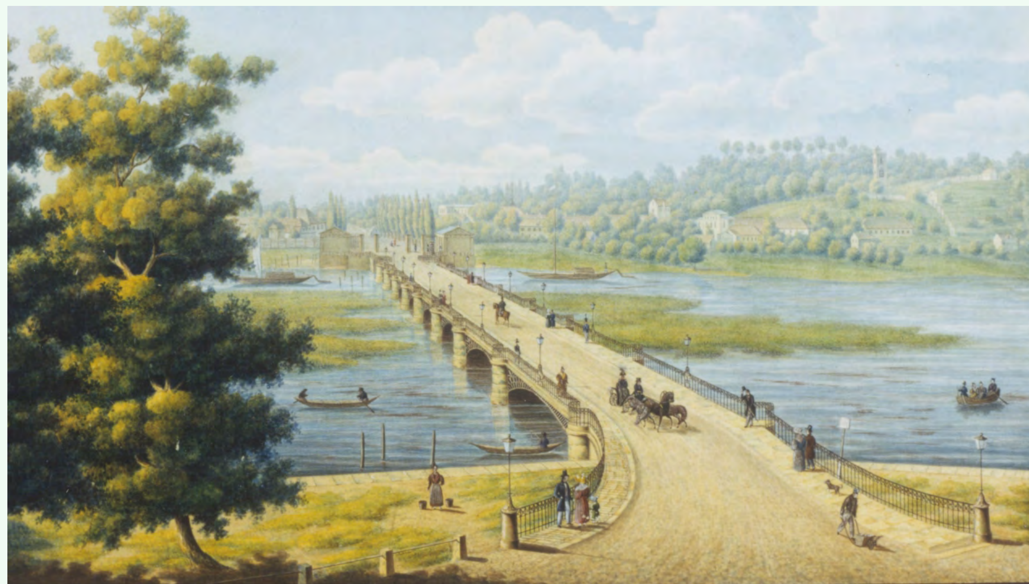
Blick auf die Gusseisenbrücke in Richtung Brauhausberg, 1834
