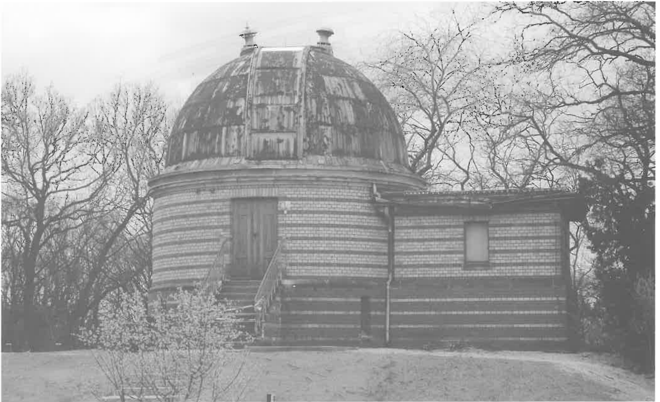
114 Potsdam, Telegrafenberg, Gebäude für den Photographischen Refraktor von Osten; Aufnahme 31.3.2008.
