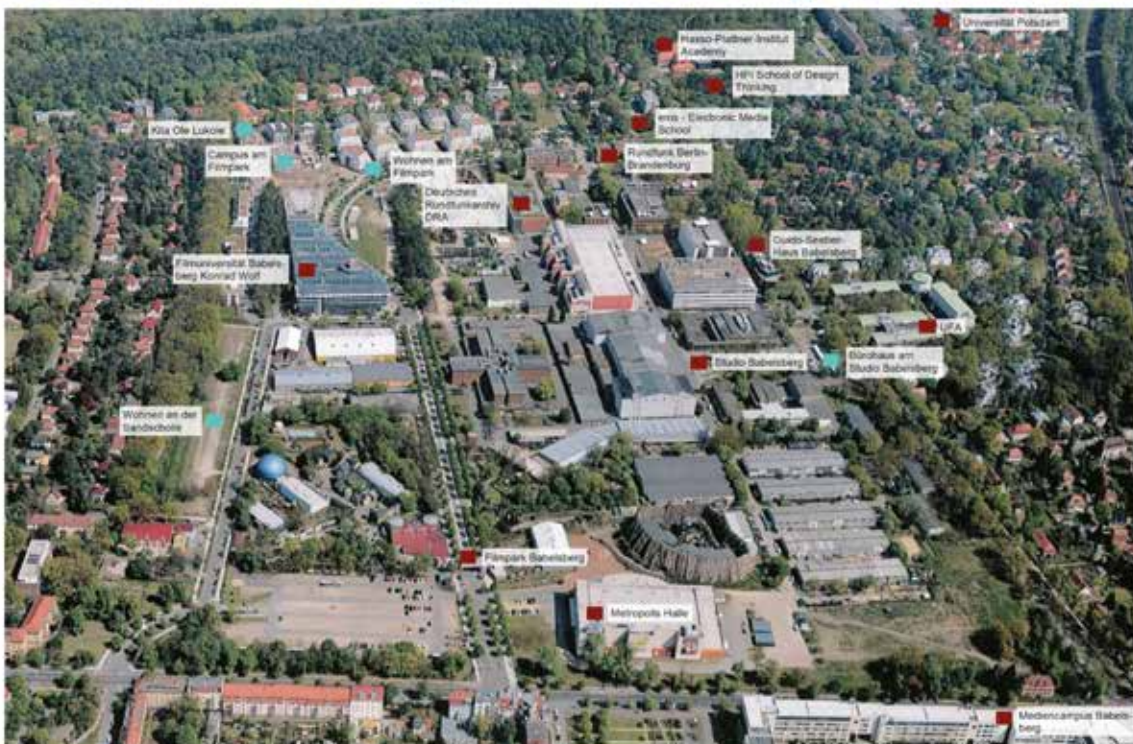
Der Gewerbestandort Medienstadt in Potsdam-Babelsberg von Süden (Auszug aus der Präsentation von Jan Kretschmar)
