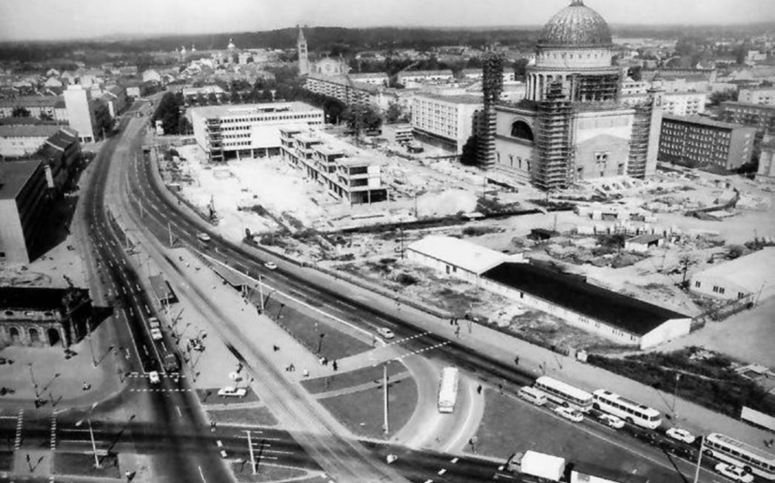
Der Bereich zwischen dem Alten Markt und der Friedrich-Ebert-Str. während des Baus der Fachhochschule (Mitte der 70er Jahre)
