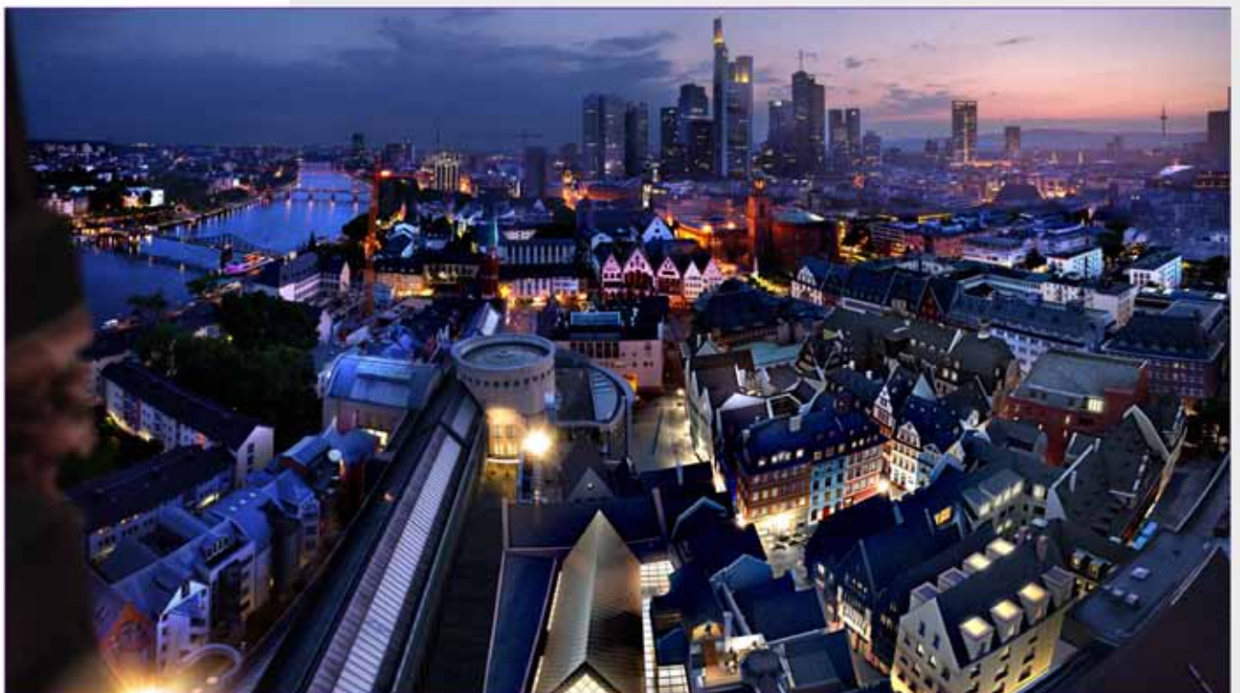
Dom-Römer-Bebauung in Frankfurt a.M. vom Osten – gegenwärtiger Zustand.
