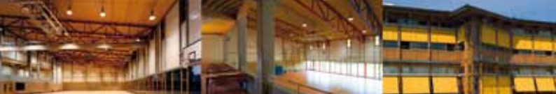
Differenzierter Neubau mit Schulbibliothek als Eingangsmotiv (Nashorn)
