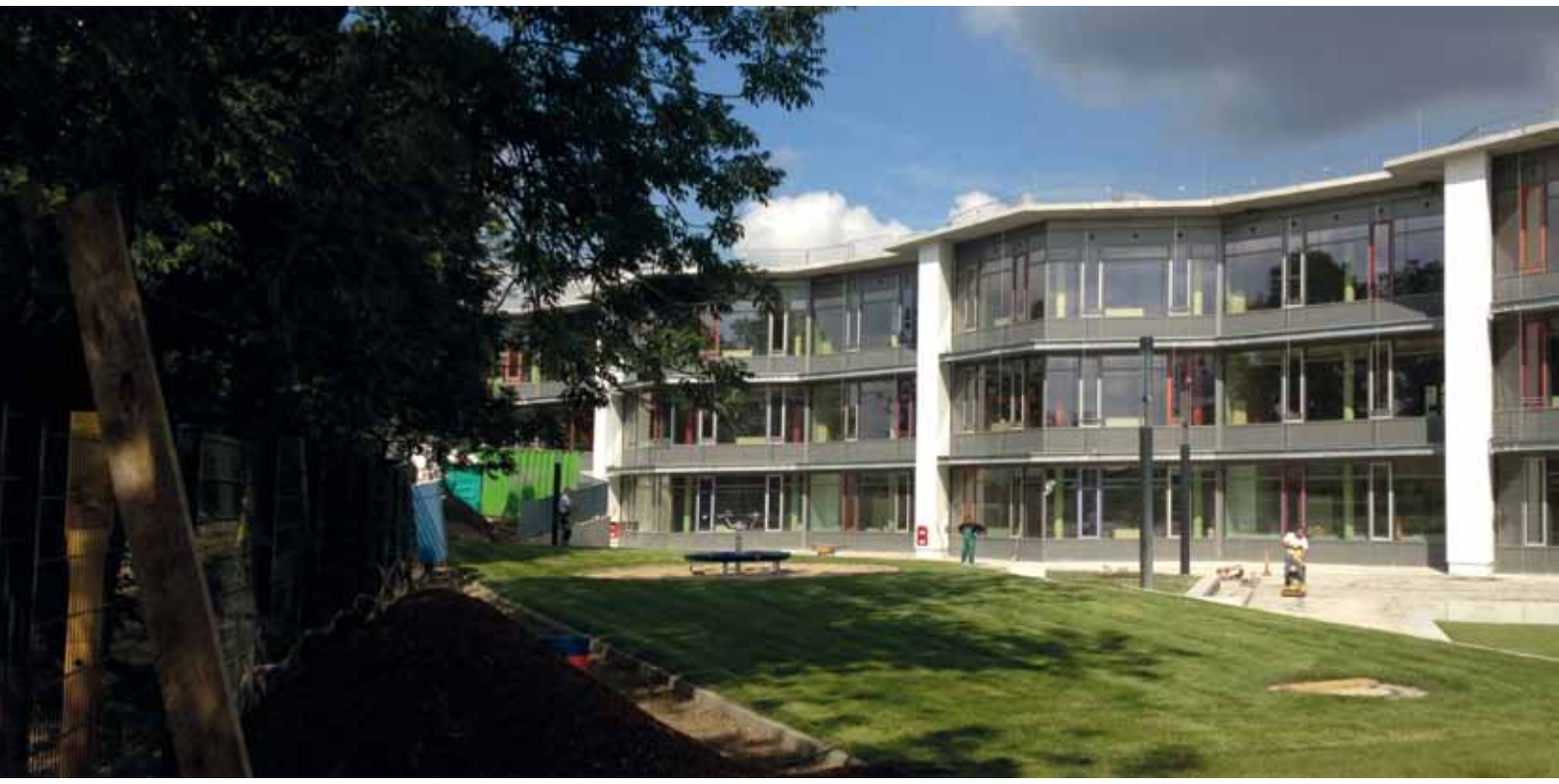
Käthe-Kollwitz-Gesamtschule Mühlentbeck (Architekten Fromme/Linsenhoff, Berlin), Ansicht von Süden.
