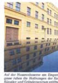
Auf der Husarenkasernen am Eingang des Kammerhaus und Bildungszentrum entworfen.
