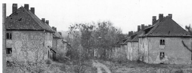
82 Gebäude der Kaserne stehen unter Denkmalschutz. Sie sollen saniert und zu Wohnungen werden - derzeit verfallen sie. Foto: JACOB UHR
