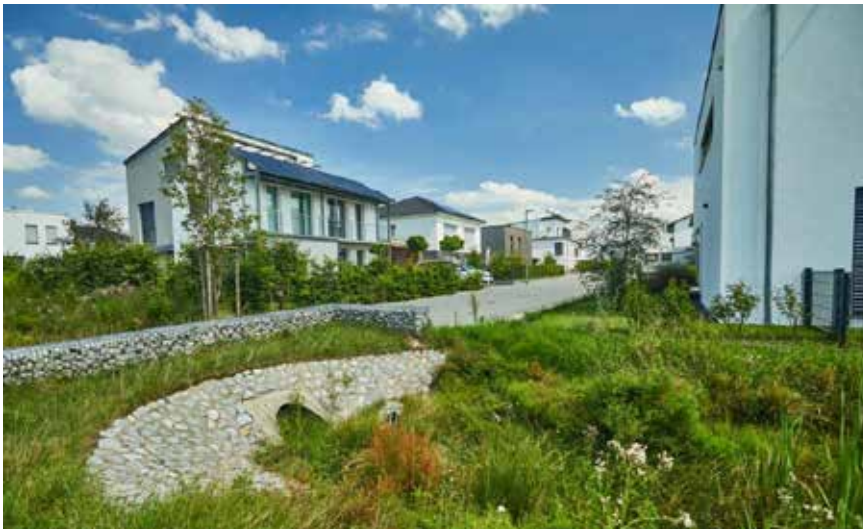
Der Zero:e-Park in Hannover-Wettbergen als Beispiel einer Nullemissions-Siedlung;
