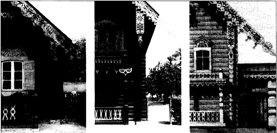
Abb. 16: Verandapfosten, Pfostenverblendungen, Giebfahnen und Stirnbrettflügel. Links: Alexandrowka (Nr. 8), Mitte: Alexandrowka (Nr. 1), rechts: Glasowo (Ausschnitt V2).
