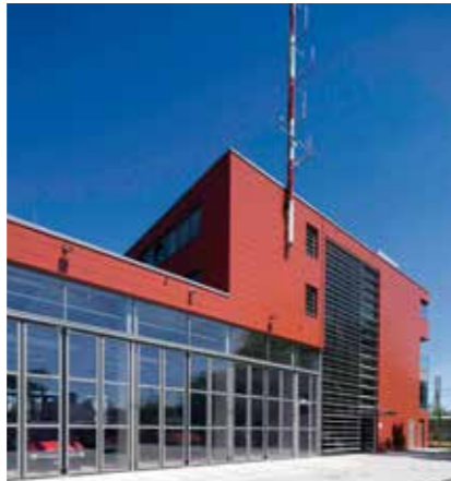
Das moderne Gebäude in der Holzmarktstraße wurde 2010 fertiggestellt. Foto: LHP/Feuerwehr Archiv
