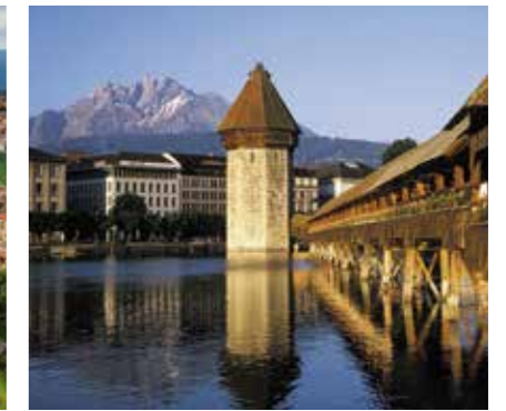
Die Kapellbrücke in Luzern ist die zweitälteste überdachte Holzbrücke Europas. Foto: Emanuel Ammon
