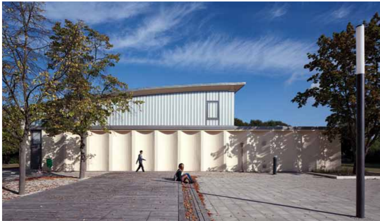
Zahlreiche Sporthallen werden in den kommenden Jahren erweitert, neu gebaut oder saniert - wie hier die Turnhalle der Zeppelin-Grundschule. Foto: LHP/Anastasia Hermann, Christian Schlicht
