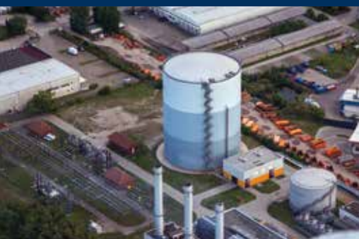
2016 in Betrieb genommen: der Wärmespeicher der EWP. Foto: Stadtwerke/Katrin Paulus
