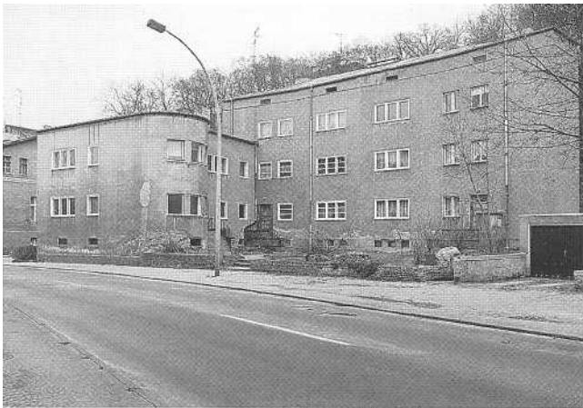
98 Heinrich L. Dietz, Mehrfamilienhaus Bley in der Leipziger Straße 57 in Potsdam, 1927; Aufnahme 1990.
