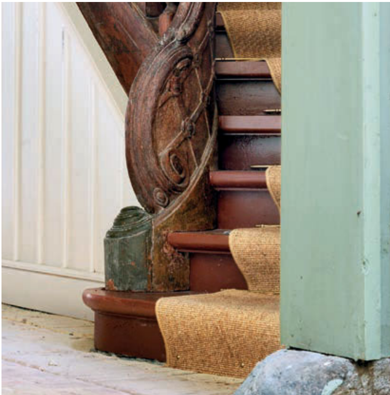
232 Treppendetail im Haus Herrmann-Elflein-Straße 27 2005
