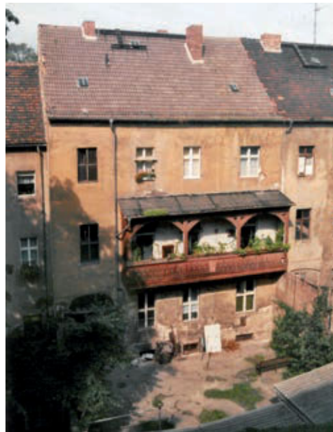
29 Detail des Hauses Dortustraße 60 nach der Restaurierung 2005
