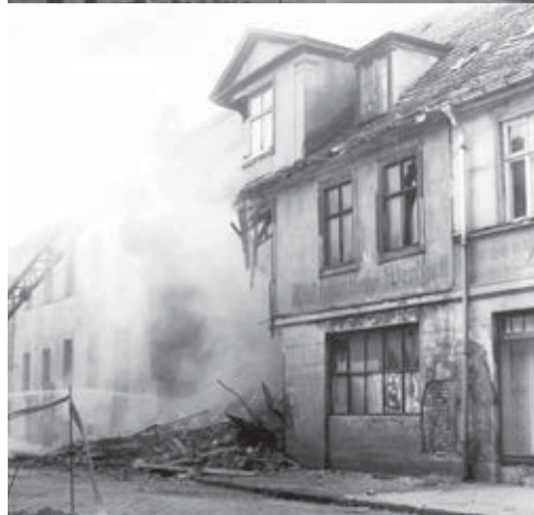
46, 47, 48, 49 Abriss Jägerstraße 9 am 16.8.1988
