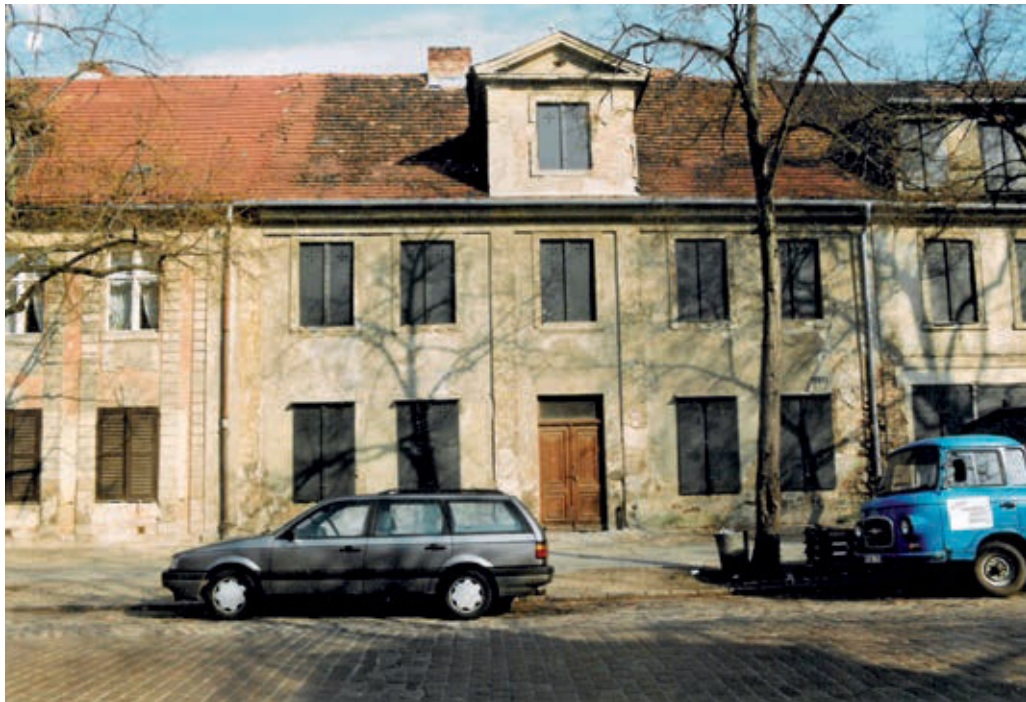
17 Das leerstehende Gebäude Lindenstraße 59 wurde von der Stadt gesichert 6.4.1991
