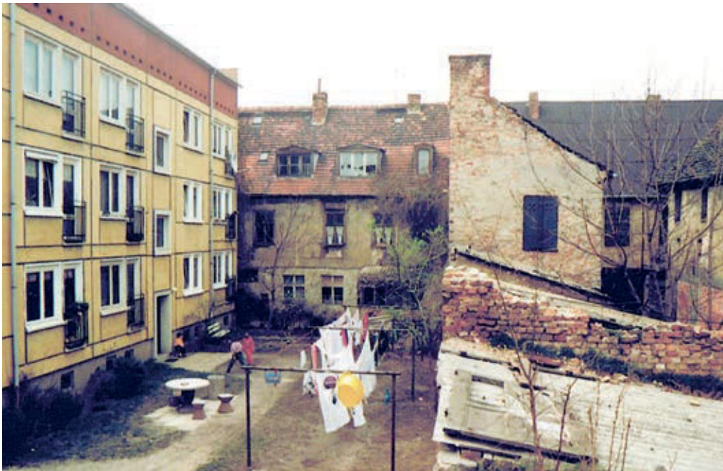
44 Hofseite des ersten Ersatzneubaus in der Gutenbergstraße 2-6 1989
