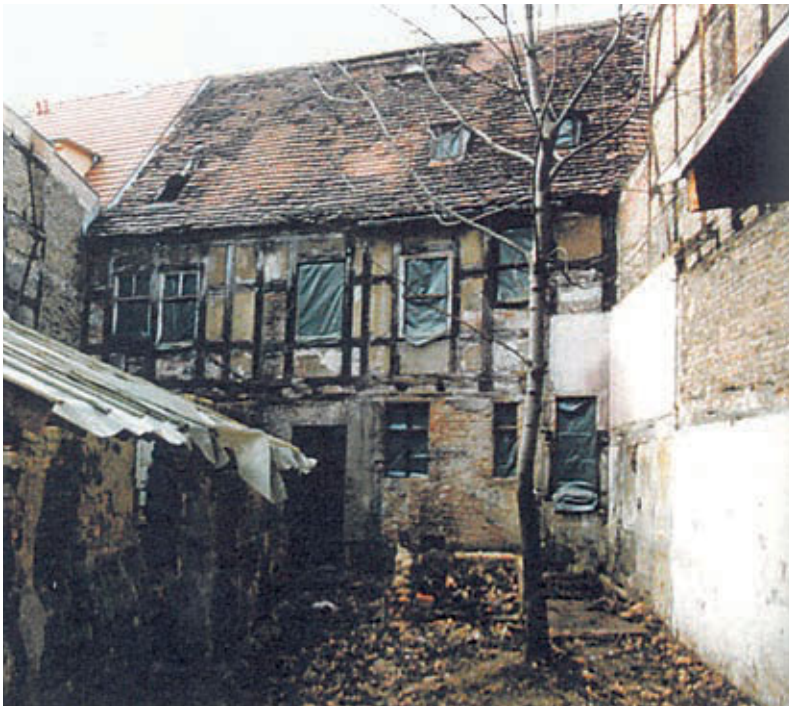
137 Dortustraße 61 Hof vor der Sanierung 1997
