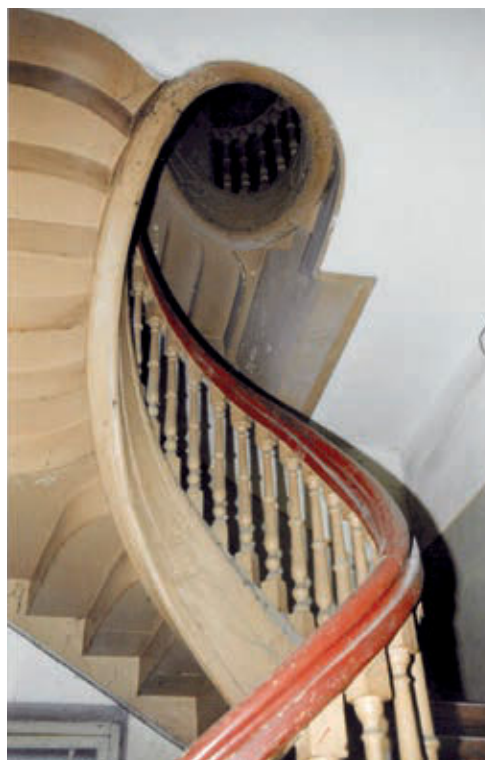
24 Blick ins Obergeschoss des Hauses Charlottenstraße 26 2012
