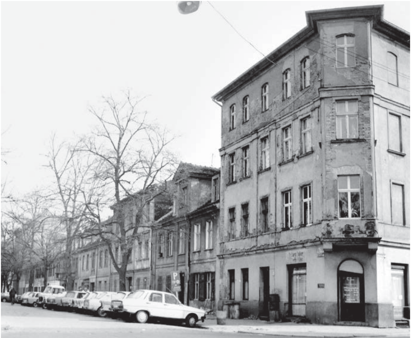
101 Dortustraße 65-73 vor dem Abriss 8.4.1989
