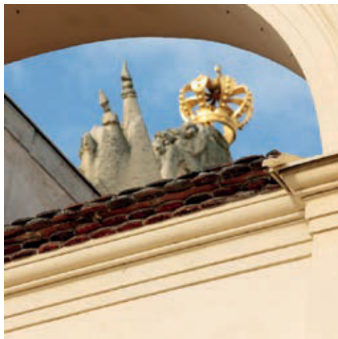
123 Brandenburger Tor Blick in den Dachbogen 2013
