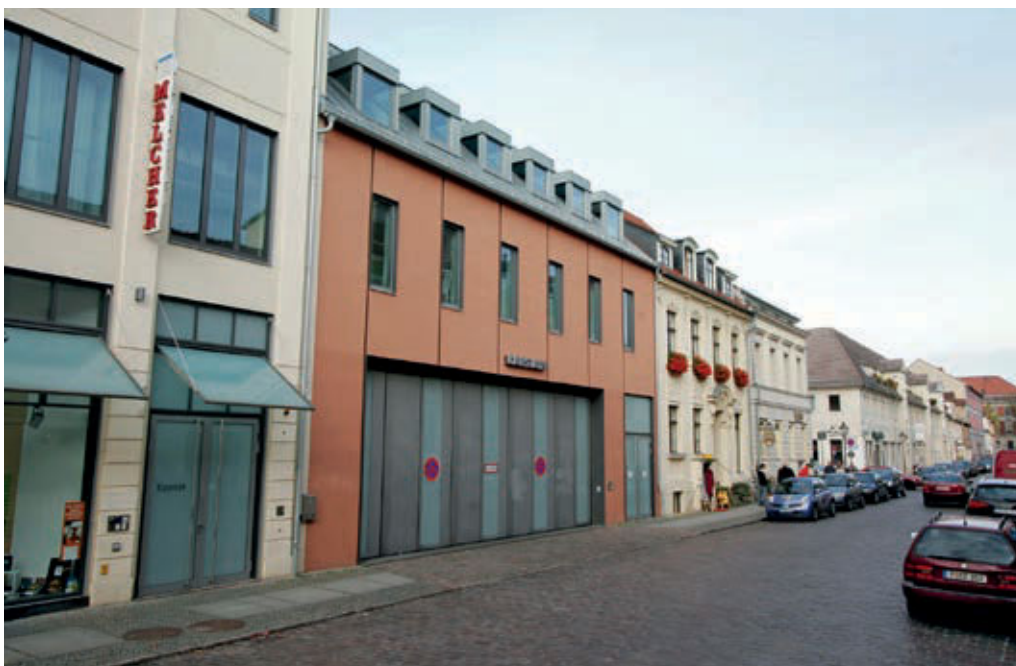
203 Neupflasterung vor dem Haus Jägerstraße 13 in gebundener Bauweise 2006
