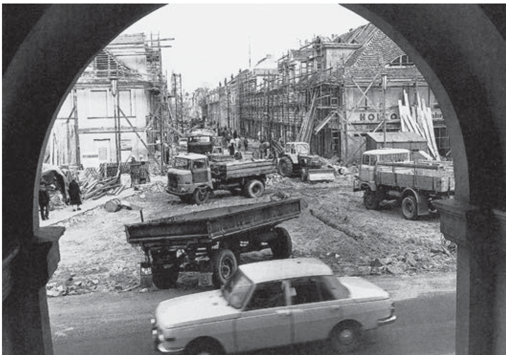
36 Blick in die Klement-Gottwald-Straße (heute Brandenburger Straße) 1977
