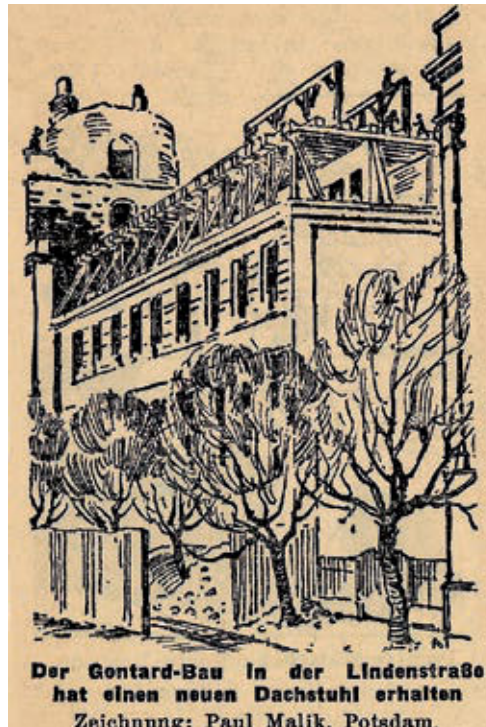
170 Neuer Dachstuhl auf dem Hauptgebäude des Waisenhauses 1950
