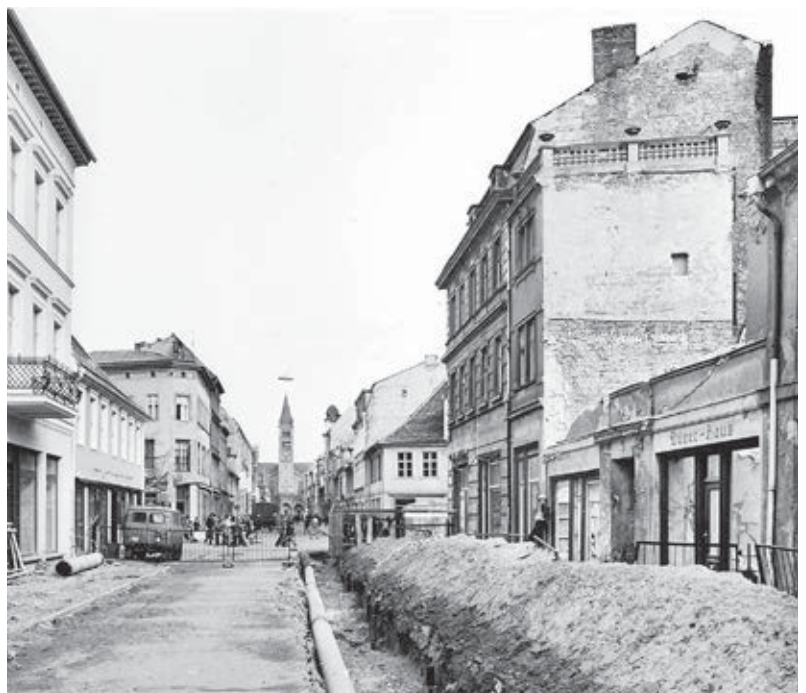
8 Brandenburger Straße während der Rekonstruktion (Rechts im Bild Haus Nr. 18 fast vollständig abgerissen) 1976
