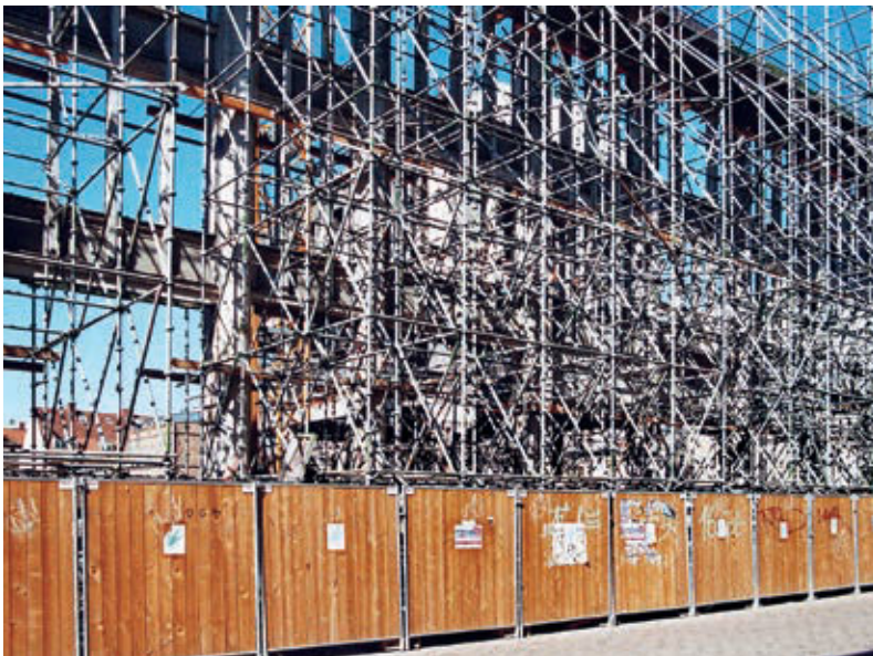
147 Stützgerüst der Fassade des Karstadtkaufhauses 2004
