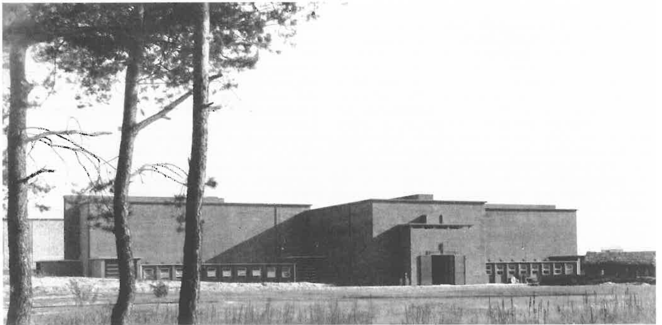
84 Potsdam, August-Bebel-Straße 26-53, Tonfilmatelier (»Tonkreuz«) von Nordosten, Otto Kohtz, 1929; in: Wasmuths Monatshefte für Baukunst und Städtebau, Jg. 14, 1930, S. 133.
