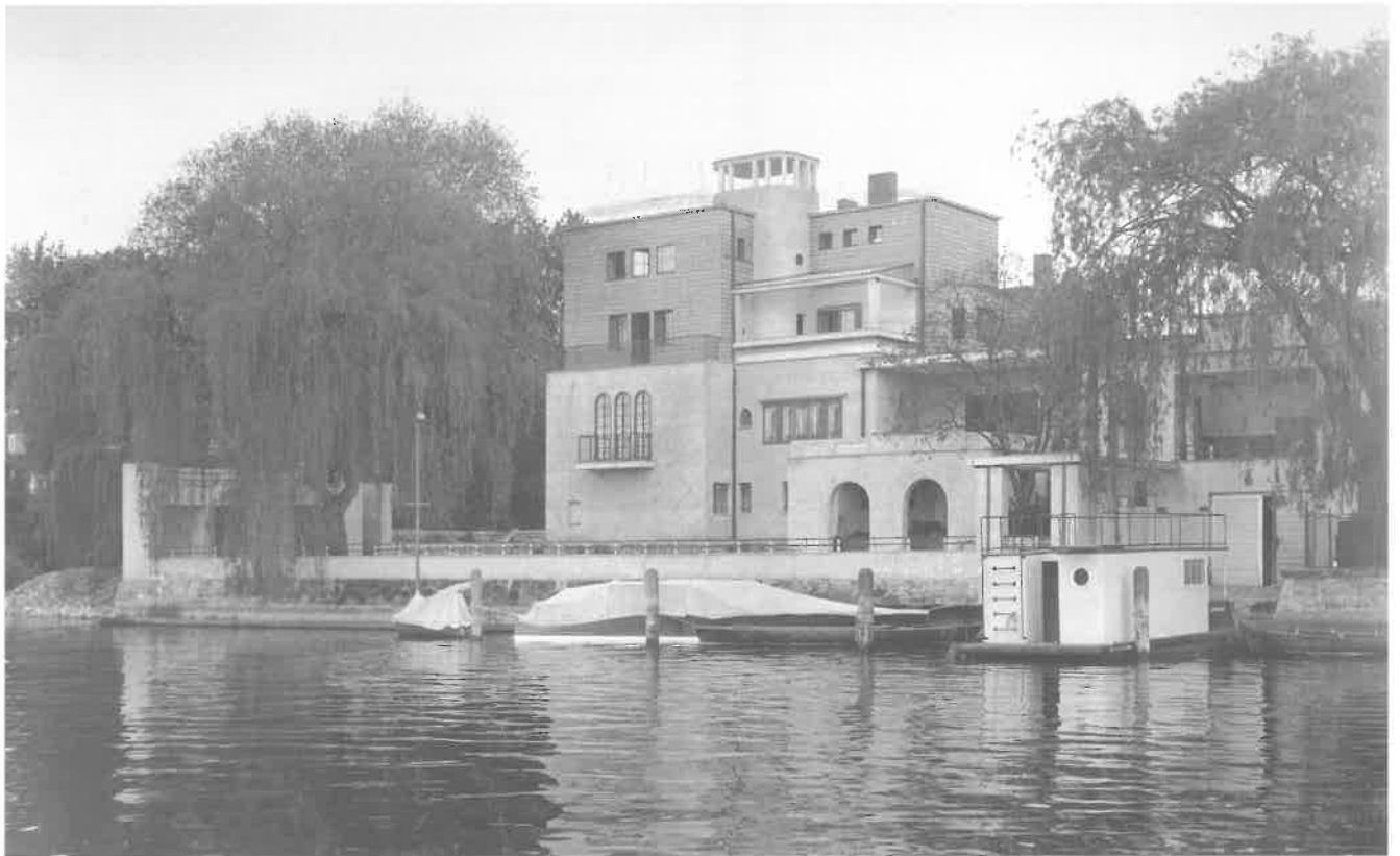
63 Potsdam, Bertinistraße 23, Villa Hagen, Eberts & Block, 1928; Potsdam, Stadtverwaltung (wie Abb. 50), Acta specialia Bertinistraße 23.
