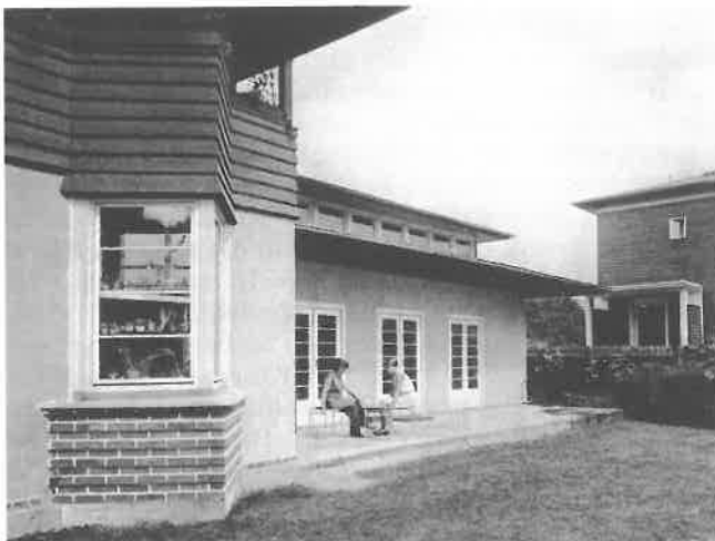
54 Potsdam, Gymnastikschule Ullrich (wie Abb. 53) von Südwesten, rechts das Wohnhaus Dietz; in: Bauwelt (wie Abb. 53), S. 5 Mitte.
