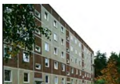
Unsaniertes Plattenbau Waldstadt II
