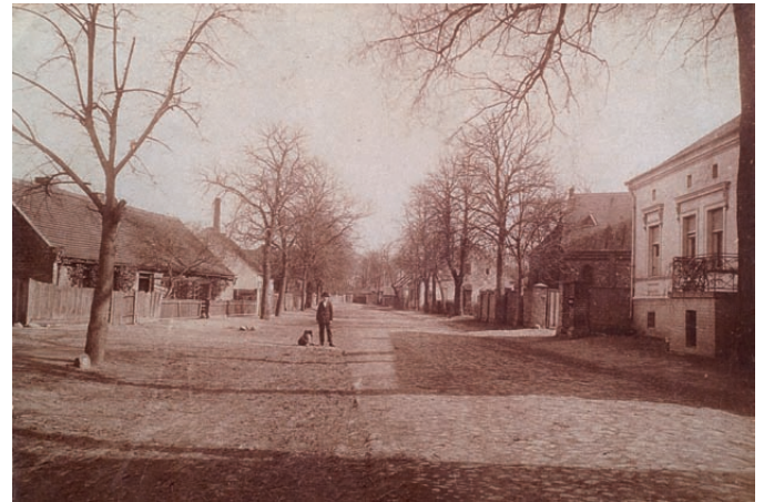
Abb. 6: Dorfstraße mit Sommerweg, mit Blick vom nordöstlichen Dorfeingang in Richtung Gutsanlage. Links im Bild ist der Schornstein der Brennerei zu erkennen. Postkarte um 1920.
