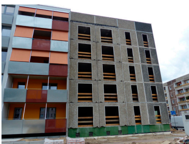
Abbildung 14: Fortführung der Gebäudesanierung im Pilotblock (Konrad-Wolf-Allee Ecke Eduard-von Winterstein-Straße)
