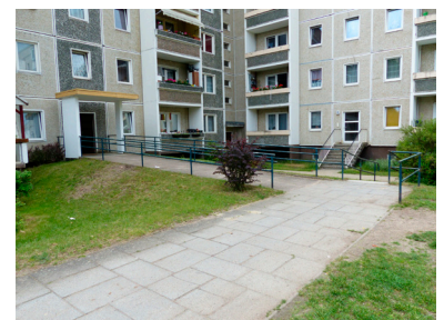
Abbildung 33: Rampe an der Günther-Simon-Straße 1
