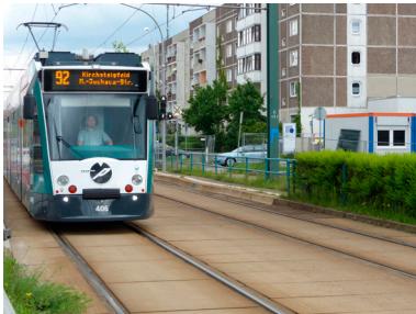
Abbildung 41: Straßenbahntrasse mit Betonplatten
