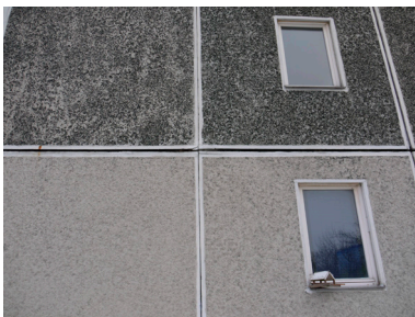
Abbildung 18: Fassade in Originalzustand
