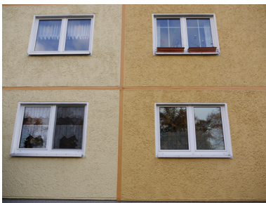
Abbildung 19: Fassade mit Fugensanierung
