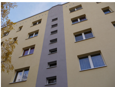
Abbildung 20: Fassade mit Wärmedämmverbundsystem
