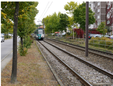
Abbildung 42: Straßenbahntrasse mit Schottergleisbett
