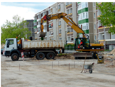
Abbildung 48: Umbau der Konrad-Wolf-Allee
