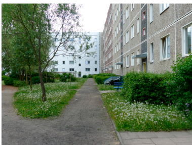
Abbildung 31: Fußweg mit wassergebundener Wegedecke
