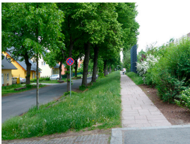
Abbildung 43: Aufschüttung des Untergrunds
