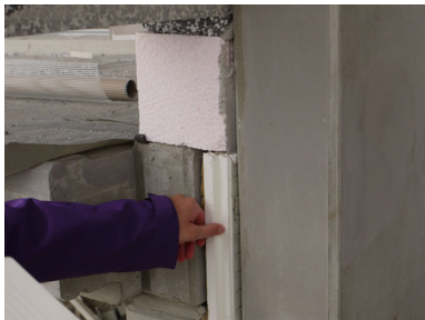
Abbildung 15: Dämmung des vorgesetzten Balkons
