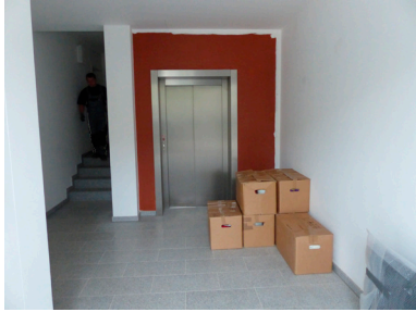
Abbildung 16: Aufzug und Treppenaufgang in einem Pilotgebäude
