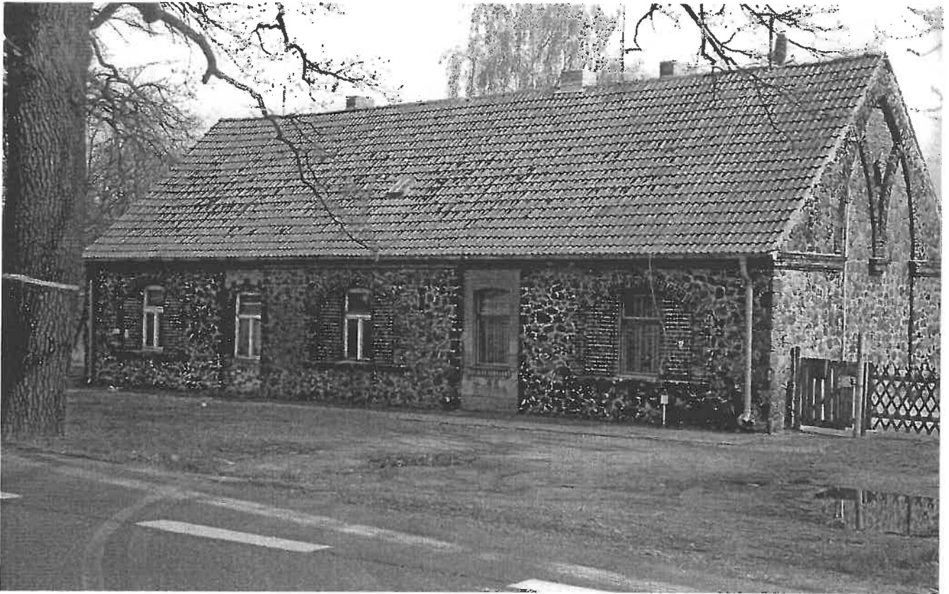
51 Chausseehaus Blumberg (Landkreis Barnim; Bundesstraße 158), erbaut vor 1806; Aufnahme 1999 (vgl. Abb. 52).
