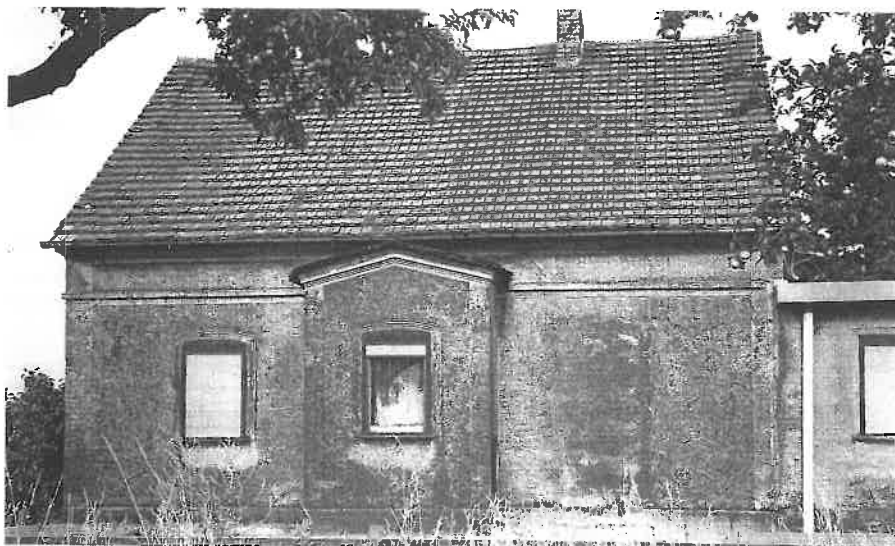
61 Chausseehaus Bohrau (Landkreis Spree-Neiße; Bundesstraße 112), erbaut um 1830; Aufnahme 1999.
