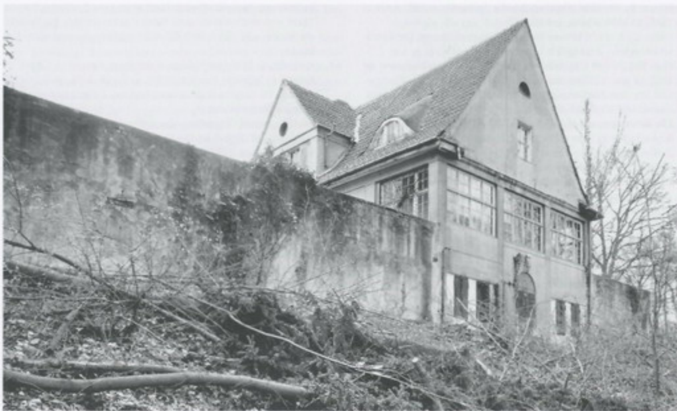
Haus Riehl. Gartenansicht. Zustand vor Sanierung 1998.
