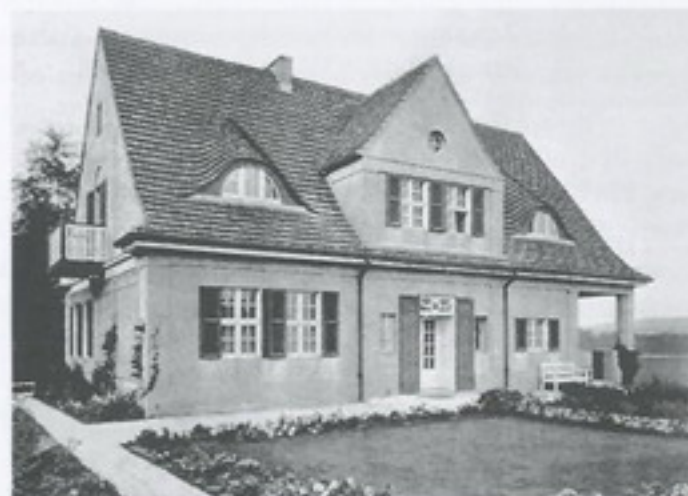
5. Vorderansicht, Zustand um 1910.
