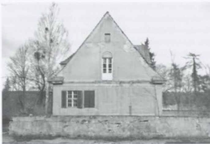
8. Giebelansicht. Zustand vor Sanierung 1998.
