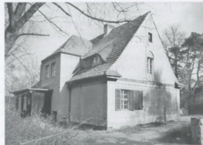
6. Nordseite, Zustand vor Sanierung 1998.
