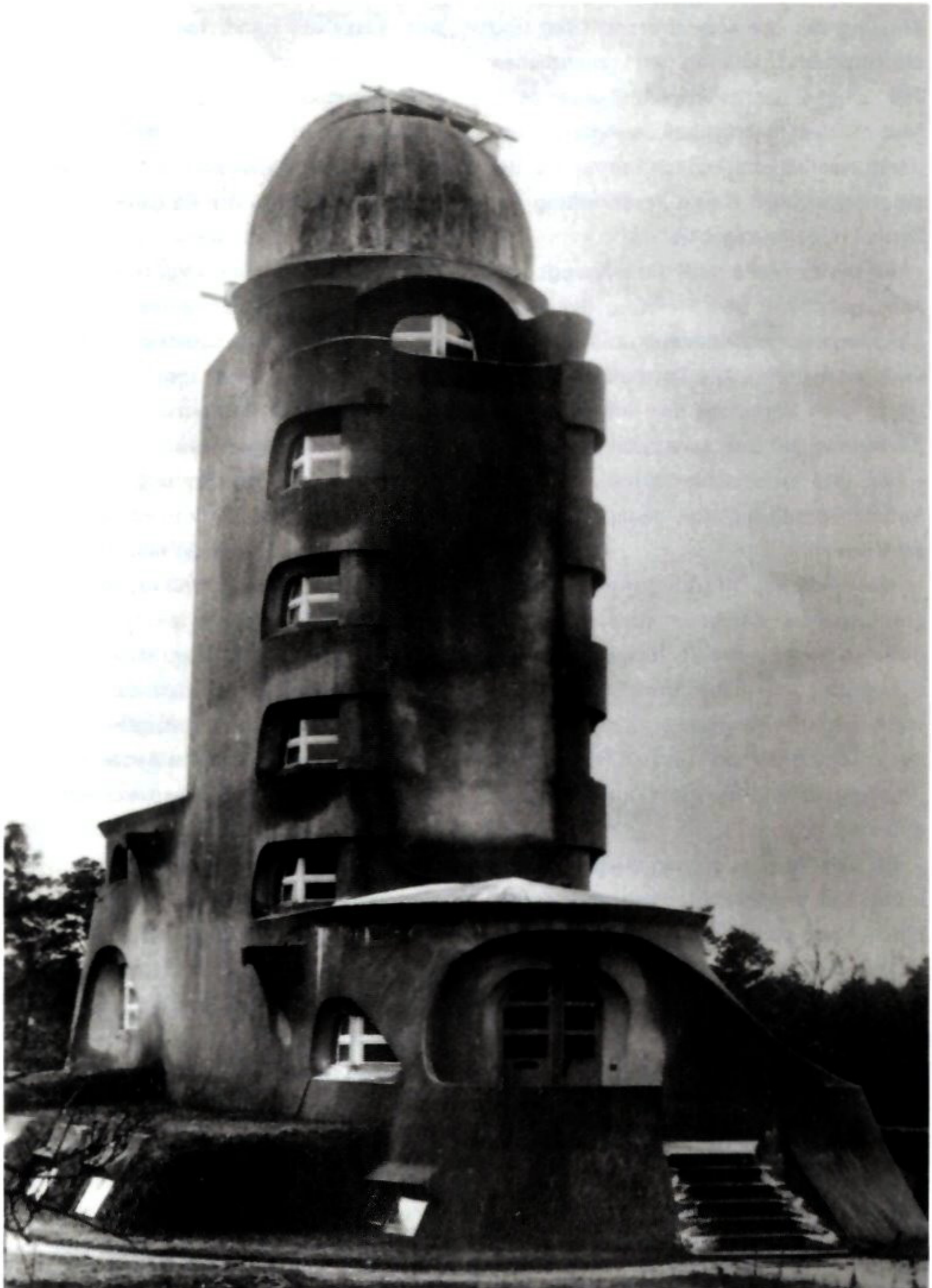
Ansicht von Nordosten, vor 1927. Die unterschiedliche Helligkeit des Turms läßt die Durchfeuchtung von Mauerwerk, Putz und Beton erkennen. Die 'große' Form ist schon in ihrer Wirkung beeinträchtigt (Postkarte).
