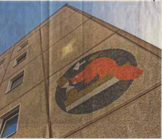
Bei der energetischen Sanierung sollen die für den Schlaatz typische Fassade wie hier am Bismarck mit Öffnung überlebt werden. FOTO: FRIEDRICH-BUNGET
