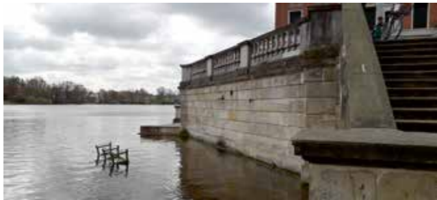
Vandalismus-Schaden am Marmorpalais im Neuen Garten
