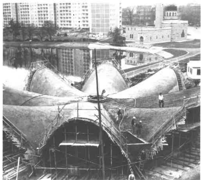
93 Potsdam, Café Seerose, Torkretierung des Betons. Landeshauptstadt Potsdam (Dokumentation Stadtentwicklung), Foto: Vera Futterlieb, 5.11.1982.
