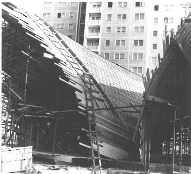
92 Potsdam, Café Seerose, Montieren der Bewehrung. Landeshauptstadt Potsdam (Dokumentation Stadtentwicklung), Foto: Vera Futterlieb, 28.10.1982.
