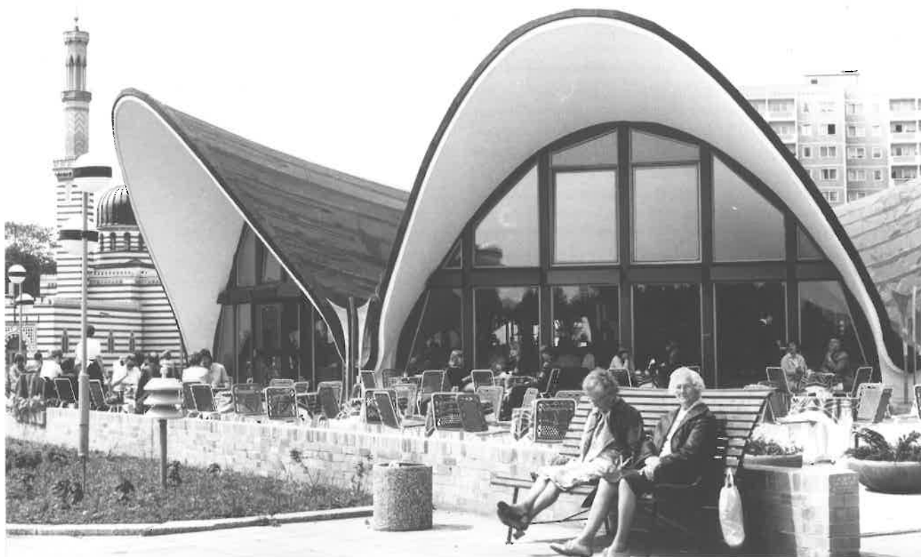
84 Potsdam, Café Seerose, Nach der Eröffnung zum Café. Landeshauptstadt Potsdam (Dokumentation Stadtentwicklung), Foto: Vera Futterlieb, 15.06.1983.
