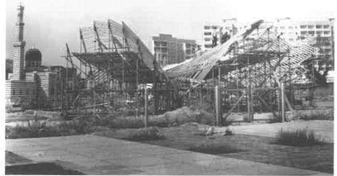
89 Potsdam, Café Seerose, Herstellung der Schalenkonstruktion. Landeshauptstadt Potsdam (Dokumentation Stadtentw.), Foto: Vera Futterlieb, 17.9.1982.
