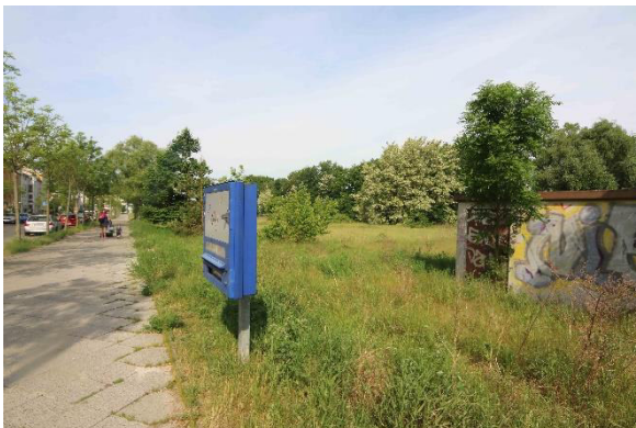
Abb. 4: Trafostation im Südosten des Gebietes
