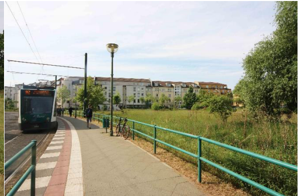
Abb. 7: Straßenbahntrasse im Osten der Fläche
