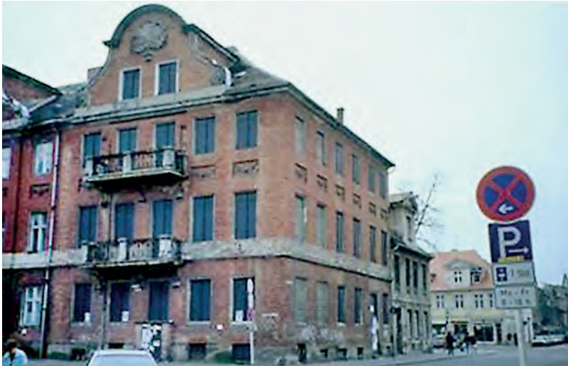
246 Haus Am Bassin 1 1995
