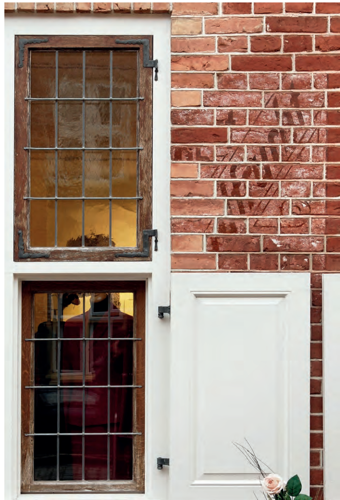
250 Fenster in der Mittelstraße 2008
