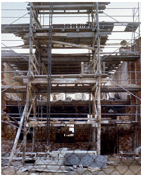
37 „Rekonstruktion“ des Hauses Mittelstraße 13 als Wiederaufbau in zweischaliger Bauweise, 1988
