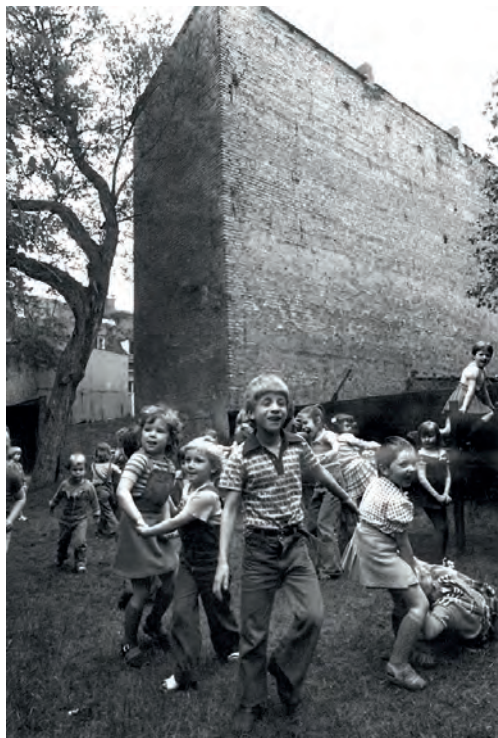
79 Im Hof des Kindergartens Benkertstraße 23 1977
