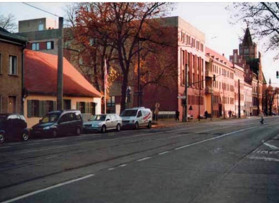
5. Behindertenwohnheim des Oberlin-Hauses in Babelsberg, Ansicht von Westen aus der Rudolf-Breitscheid-Str. (1979-1980)
