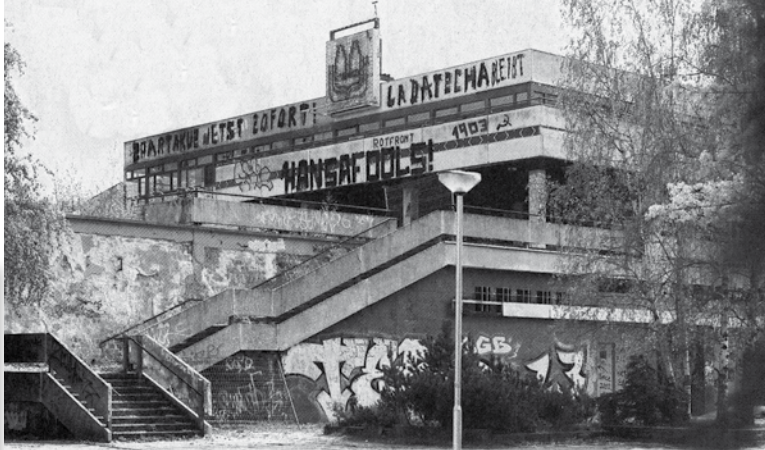
Ein Blick des Jammers. Seit 15 Jahren gammelt das einst beliebte Terrassenrestaurant „Minsk“ vor sich hin. Benannt wurde es nach der Hauptstadt Weißrusslands, damals Partnerstadt von Potsdam. Inzwischen mehren sich die Stimmen, die einen Erhalt des DDR-Bauwerks fordern. Foto: Andreas Klair
