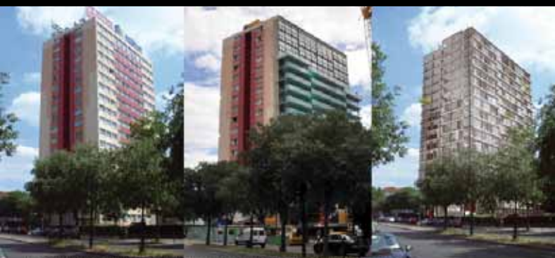
vorher / umbau / nachher, Tour Bois-le-Prêtre, Paris 2011, Druot, Lacaton & Vassal
