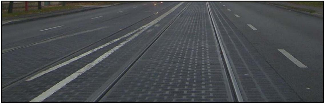
**Abb. 77** Gleiseindeckung mittels Pflaster
