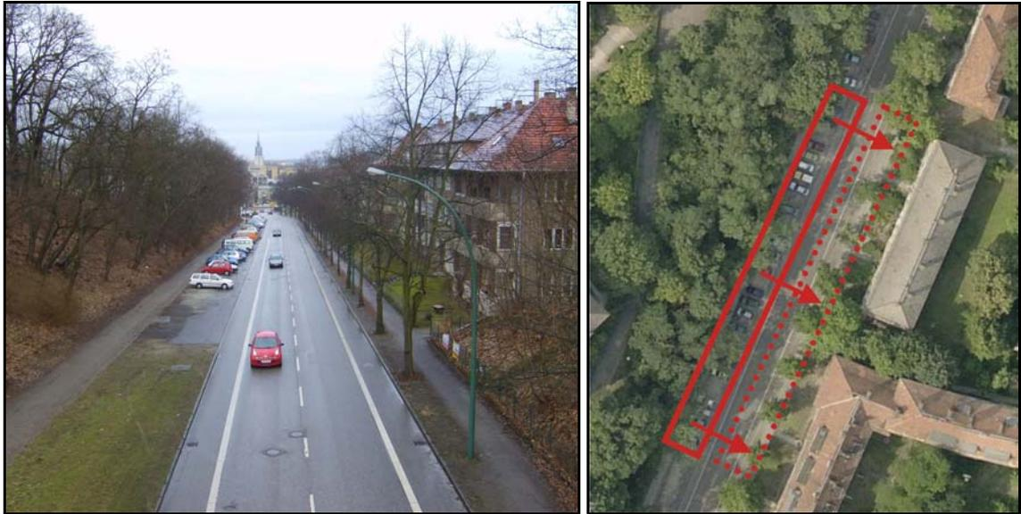
**Abb. 69** Brauhausberg – Verlagerung der Fahrbahn in Richtung Westen
