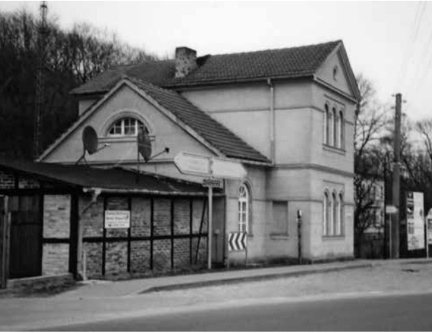
Abb. 3: Chausseehaus in Schiffmühle an der Bundesstraße 158, um 1834, Foto: Sabine Ambrosius / Gabriele Horn, 1999.
