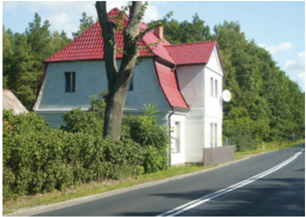
6 Chausseehaus Altenfließ (Przyłęg), Fernverkehrs- straße 22, um 1825 (Foto: Ambrosius/Horn 2009)
