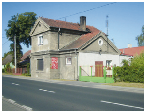
5 Chausseehaus Gennin (Jenin), Hauptverkehrs- straße 132, um 1825 (Foto: Ambrosius/Horn 2009)
