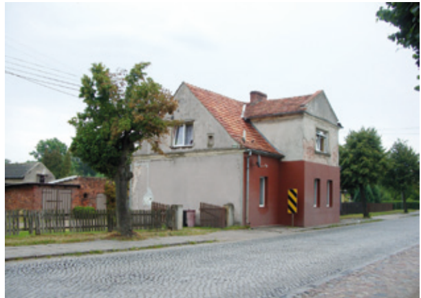
7 Chausseehaus Ziebingen (Cybinka), Fernverkehrs- straße 29, 1817–1819 (Foto: Ambrosius/Horn 2009)
