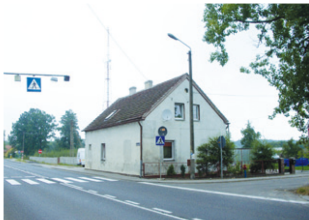
3 Chausseehaus Groß Lessen (Leśniów Wielki), Fernver- kehrsstraße 32, um 1805 (Foto: Ambrosius/Horn 2009)
