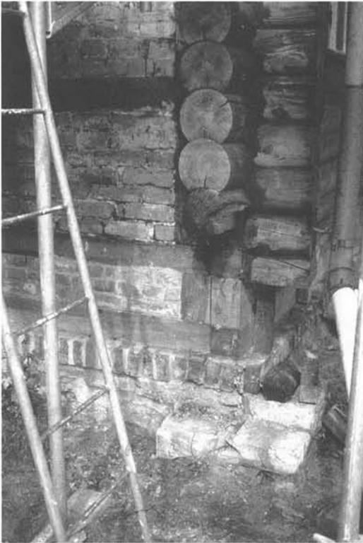
7 Ecke des Hauses Alexandrowka Nr. 5. Auf dem Kalksteinfundament liegt eine Ziegelrollschicht auf der die Grundschwelle liegt. Man kann gut die früheren Fachwerkverkürzungen und bei der Restaurierung die erneute Verlängerung erkennen. Deutlich sichtbar sind die Scheinecküberkämmungen, die tatsächlich nur in den Eckständer eingezapft sind.
