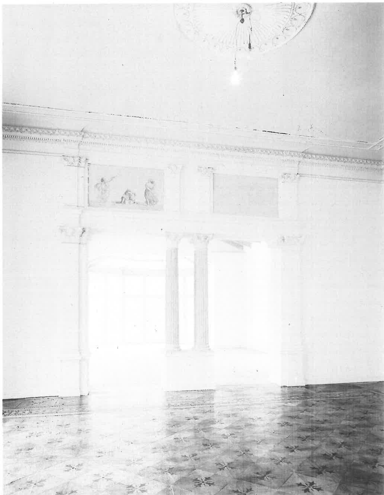
68 Potsdam, Villa Henckel, Blick vom Großen Saal in den Wintergarten nach der Sanierung; Aufnahme März 2010. Oben links die Supraporte mit spielenden Musen und Putti (vgl. Abb. 69 f.).
