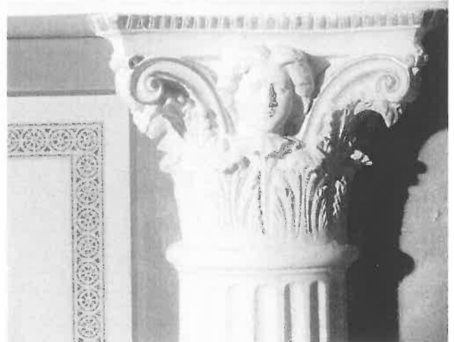
67 Potsdam, Villa Henckel, Muster zur bauzeitlichen Farbgebung in der Eingangshalle; Aufnahme Januar 2009.
