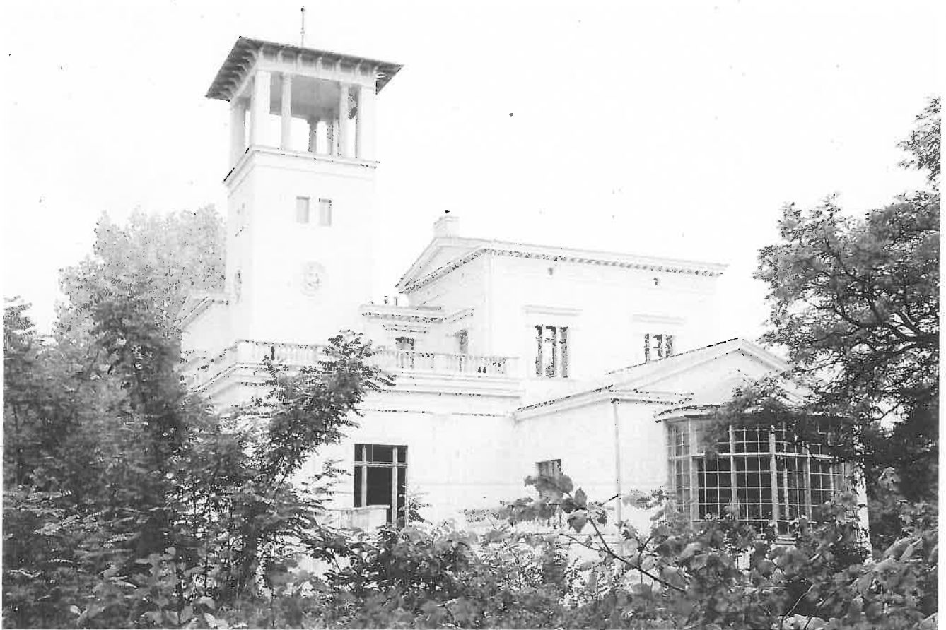
57 Potsdam, Villa Henckel von Süden im sanierten Zustand; Aufnahme Oktober 2010.
