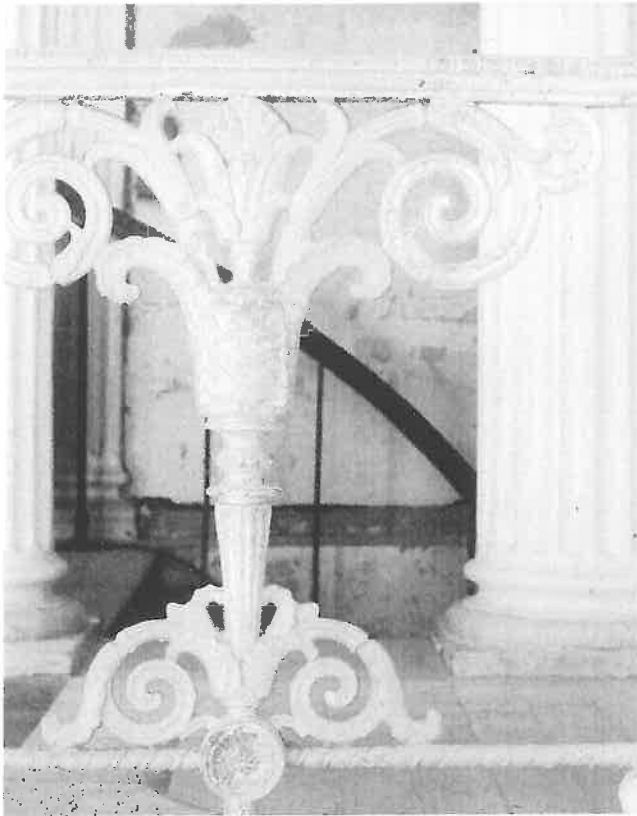
65 Potsdam, Villa Henckel, Zinkgussgeländer in der Eingangshalle während der Bearbeitung; Aufnahme Mai 2008.
