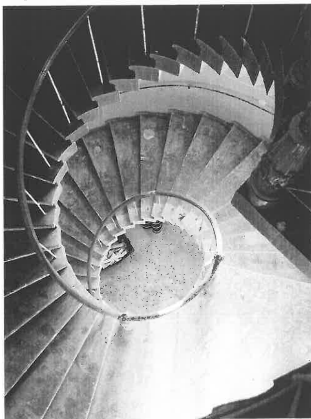
76 Potsdam, Villa Henckel, Turmtreppenhaus vor der Sanierung; Aufnahme April 2009.
