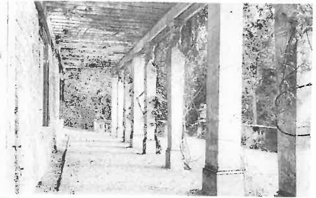
78 Potsdam, Villa Henckel, Pergola an der Ostseite (Talseite), architektonisches Bindeglied zwischen dreigeschossiger Gartenfassade und Hang, die im Zusammenhang mit der Gartenrestaurierung wieder hergestellt wird; Postkarte um 1930, beschriftet »Wandelgang« (Postkartensammlung zum »Haus Sonnenstätte«); Privatbesitz.
