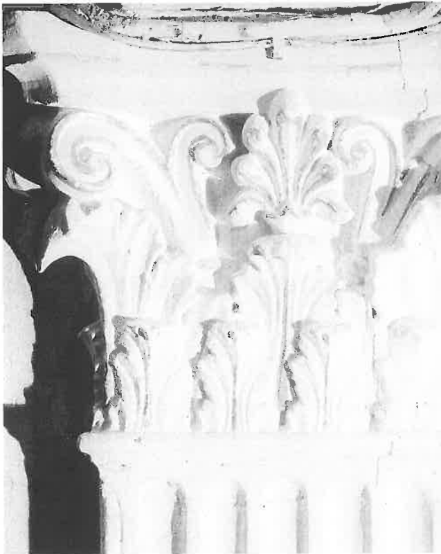
66 Potsdam, Villa Henckel, Kapitell im Flur des Erdgeschosses während der Bearbeitung; Aufnahme Mai 2008.
