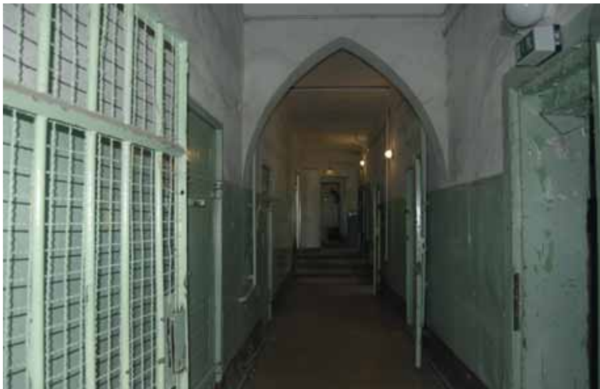
Abb. 3 – Gedenk- und Begegnungsstätte Leistikowstraße, Flur im Erdgeschoss – Zustand vor der Sanierung, 2006
