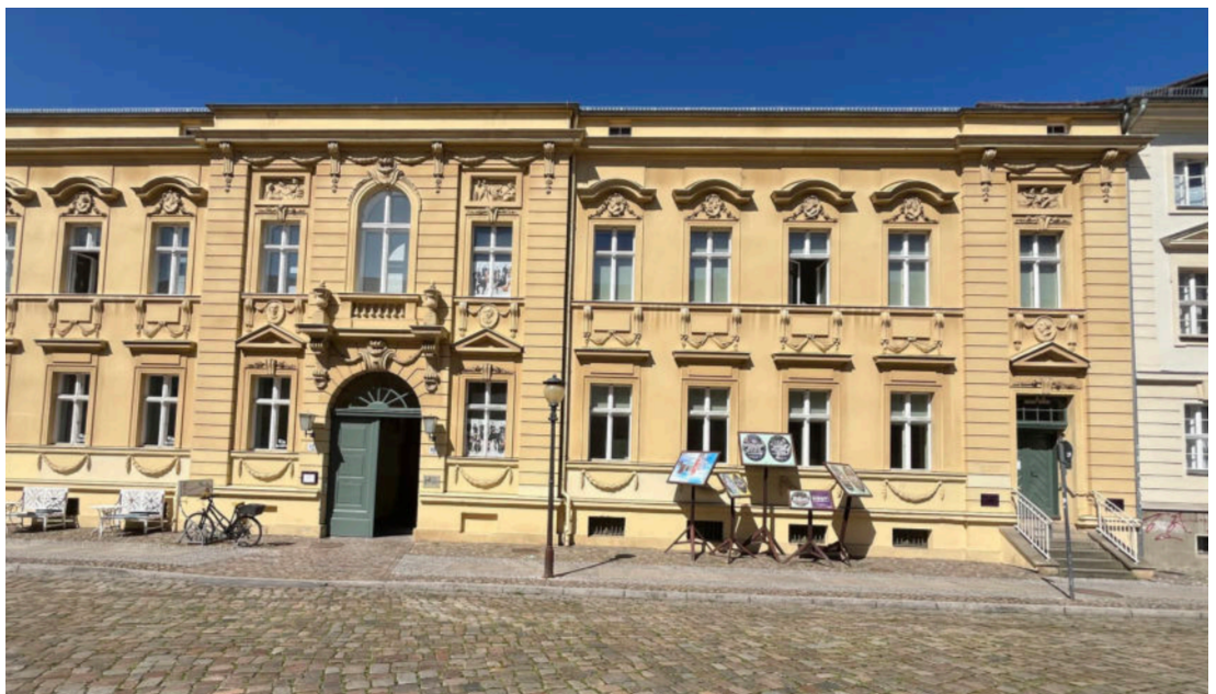
14 Nikolaisaal Eingang Wilhelm-Staab-Straße
