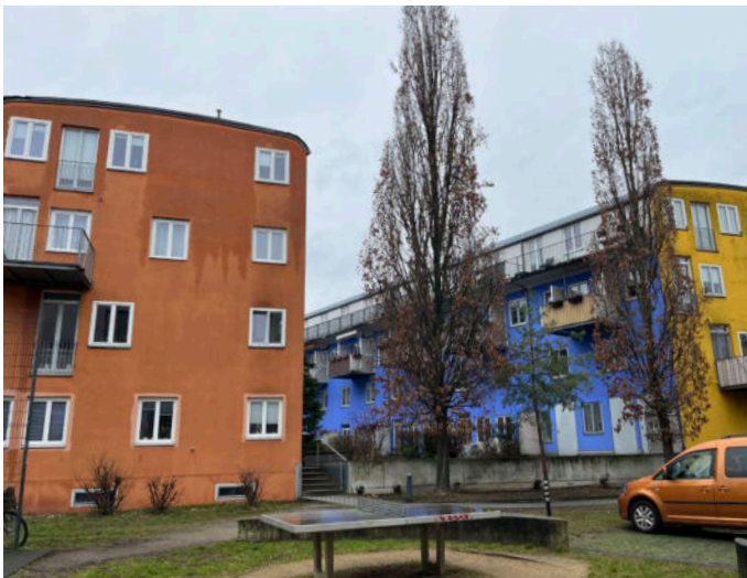
17 Wohnungsneubau 1. BA Hofansicht
