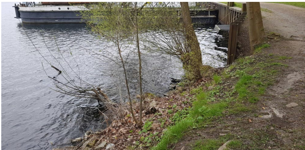
Abb. 4: Spundwand und Steinschüttung als Uferbefes- tigung
