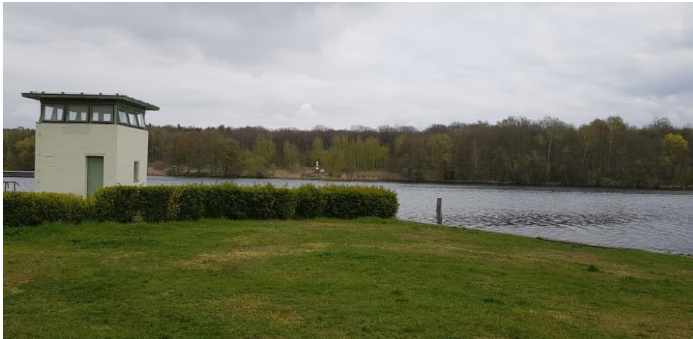
Abb. 16: Offene Bereiche um ehem. Grenzkontroll- punkt
