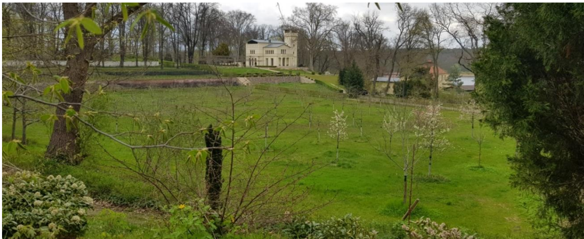
Abbildung 255: Villa Jacobs mit Gartenanlage (Stadt Land Brehm April 2021)
