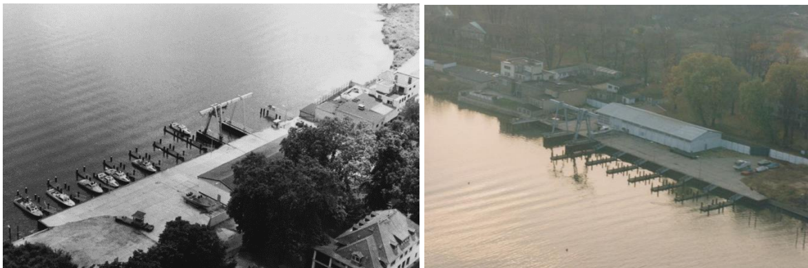
Abbildung 4: Anlagen der NVA-Bootskompanie, Zustand ca. 1990 5
