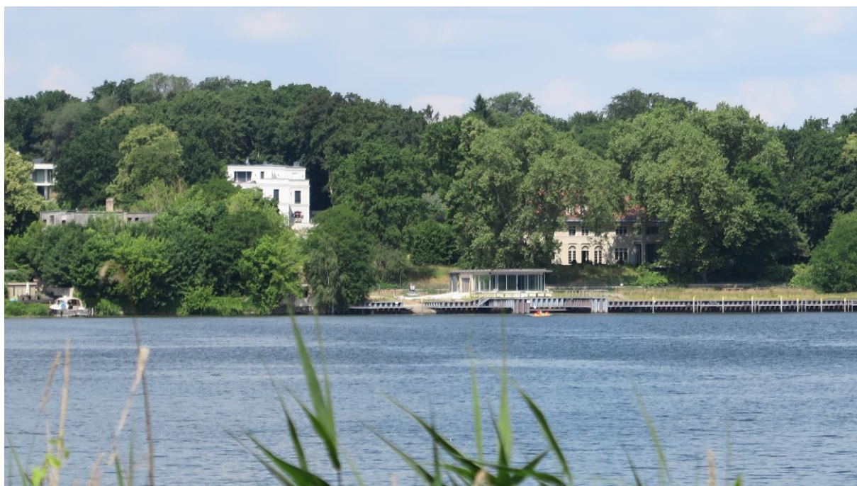
Abbildung 2: Blickrichtung Baustelle Bootshaus und Steganlage 2
