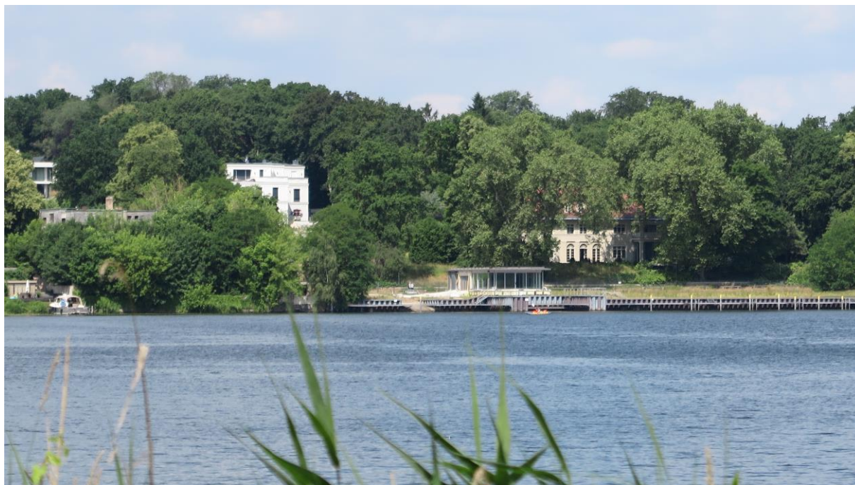
Abbildung 11: Baustelle Bootshaus mit Stegen 12
