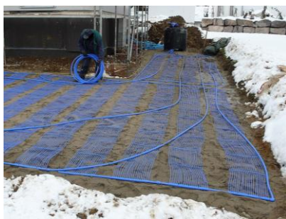
Erdwärmesonden und -kollektoren
