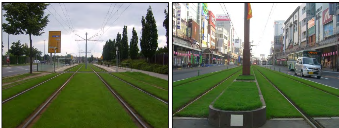
Abb. 40 Beispiele für hochliegendes Rasengleis Dresden, Japan
