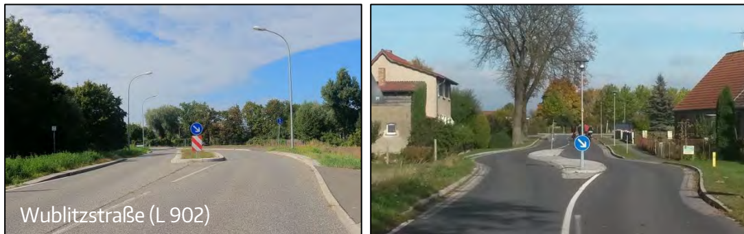
Abb. 35 Beispiele Ortseingangsgestaltung mit Fahrstreifenversatz
