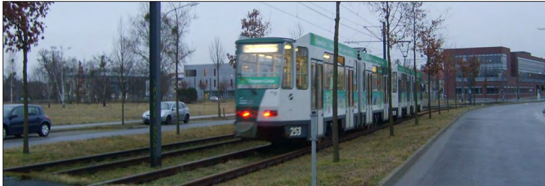
Abb. 41 Beispiel tiefliegendes Rasengleis Potsdam
