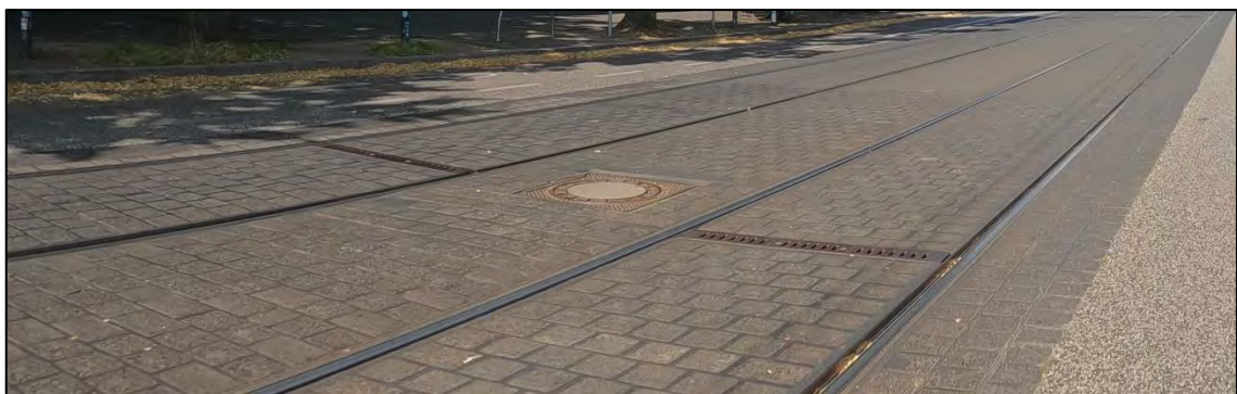
Abb. 42 Gleiseindeckung mittels Pflaster
