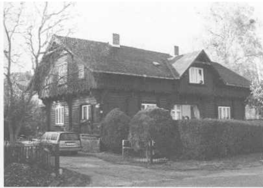
12 Wohn- und Werkstattgebäude
