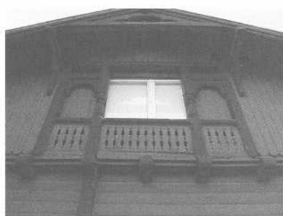
19 Haus des Stationsleiter, Loggia im Obergeschoss
