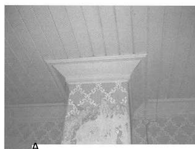
21 Wohn- und Werkstattgebäude, Obergeschoss, Deckenprofil
