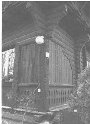
33 Wohn- und Werkstattgebäude, Eckloggia mit Balusterbrettern
