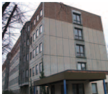
Derzeitiges Gebäude, Jägerallee 8
