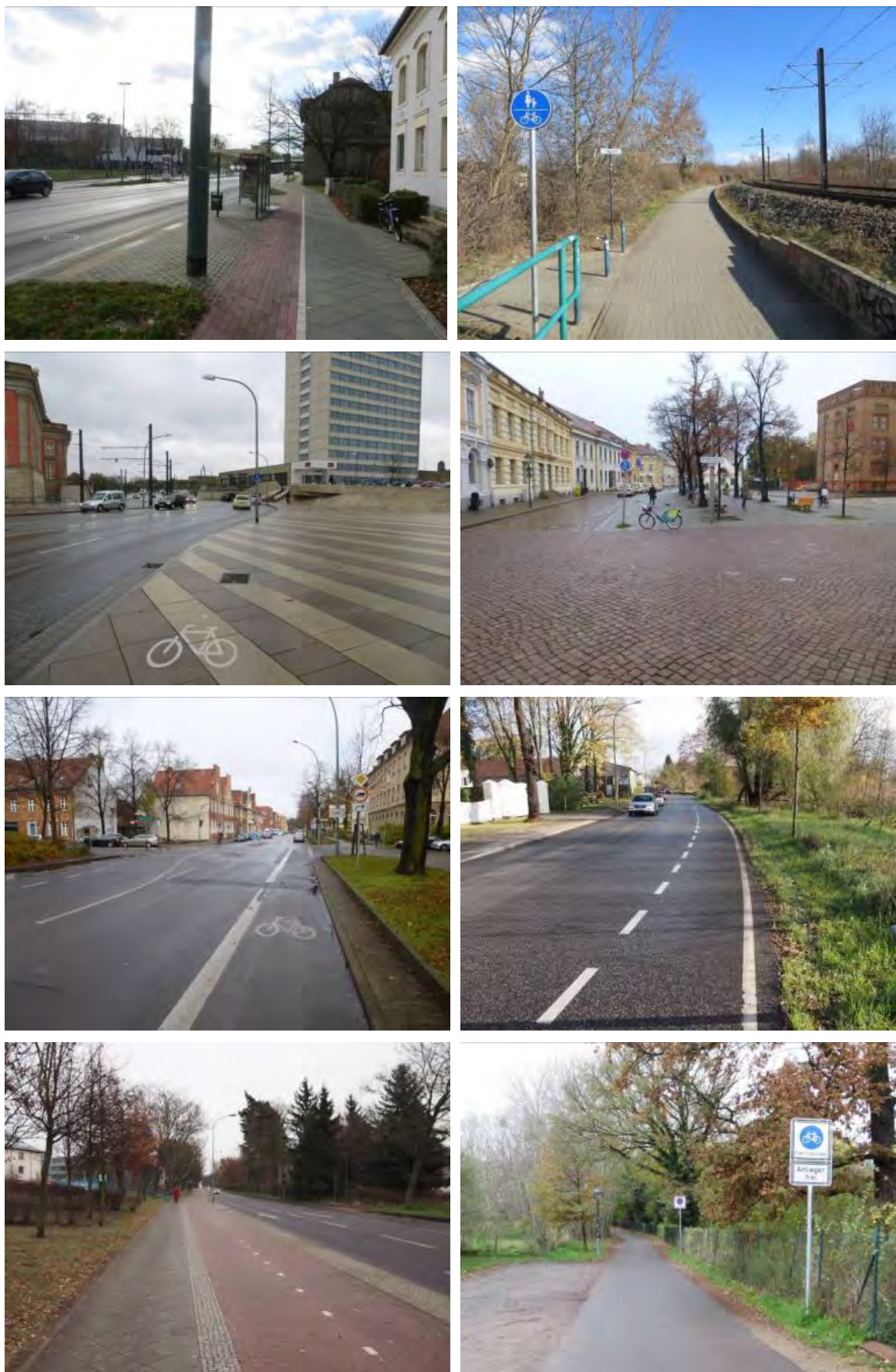
Abbildung 4: Beispielhafte Radwegeinfrastrukturen in Potsdam
