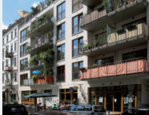
Beispiel Markthof, nachbarschaftliche Hilfe im Karolinenviertel Marktstraße 102, 16 Wohnungen, davon 2 rollstuhlgerechte Wohnungen. Architekten: überNormalnull und Planungsbüro Deichstraße
