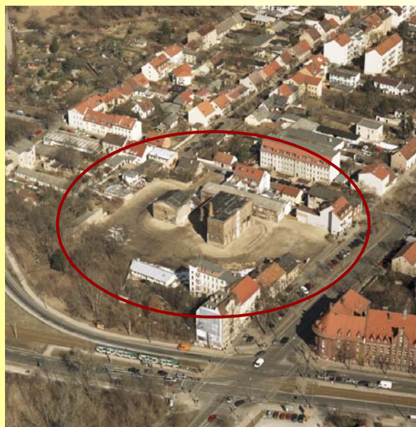
... und 2006 nach der Beräumung
