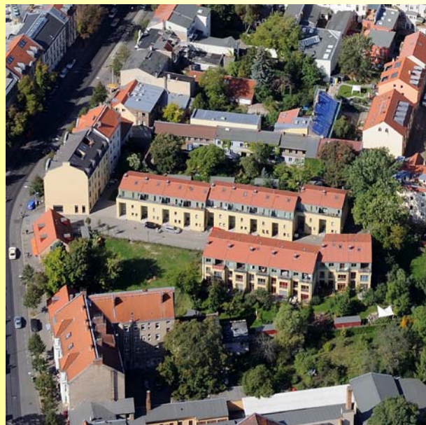
Baugemeinschaft Weberviertel – Fertigstellung der 17 Stadthäuser, Aug. 2005
