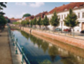
Der Stadtkanal entsteht neu
