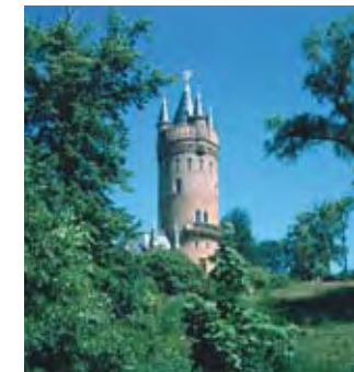
La Torre de Flatow
