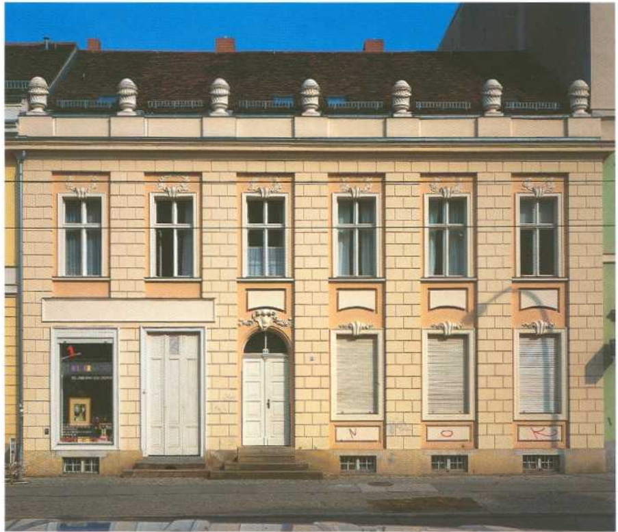
Zweite barocke Stadterweiterung, Charlottenstraße 117, 1780. Alle rustizierten Architekturteile wurden „Lederfarb“ gefasst, die Rücklage erscheint in einem blasse ziegelroten Farbton. Die restauratorische Untersuchung dokumentiert eine rote Fugenfassung im gequadrerten Bereich, die Vasen setzen sich im hellen „steinigen“ Farbton vor der dunklen Dachfläche gut ab. Foto: Hans Bach, 2006
