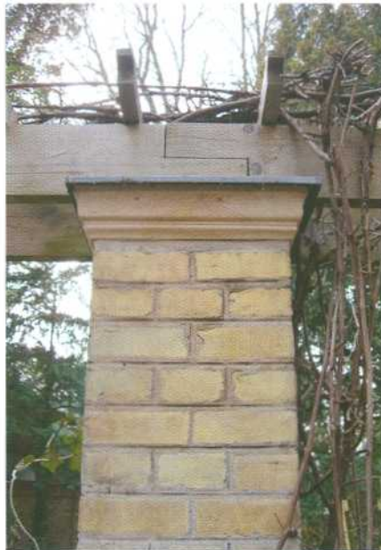
Pfeiler werden traditionell im Pfeilerverband aufgerichtet (siehe links). Der heute vielfach für Pfeiler verwandte Schornsteinverband (siehe rechts) ist an denkmalgeschützten Objekten nicht genehmigungsfähig.
