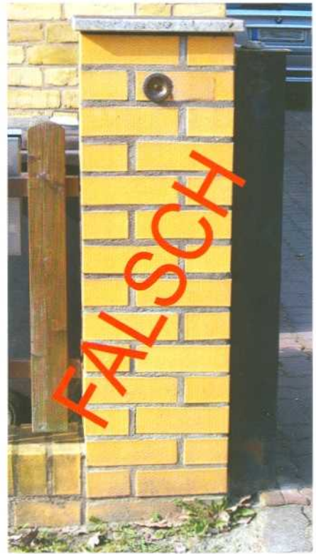
Pfeiler werden traditionell im Pfeilerverband aufgerichtet (siehe links). Der heute vielfach für Pfeiler verwandte Schornsteinverband (siehe rechts) ist an denkmalgeschützten Objekten nicht genehmigungsfähig.
