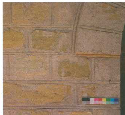
Forsthaus am Südtor, Detail der Ziegelfassade. Foto: Doreen Duras, 2005
