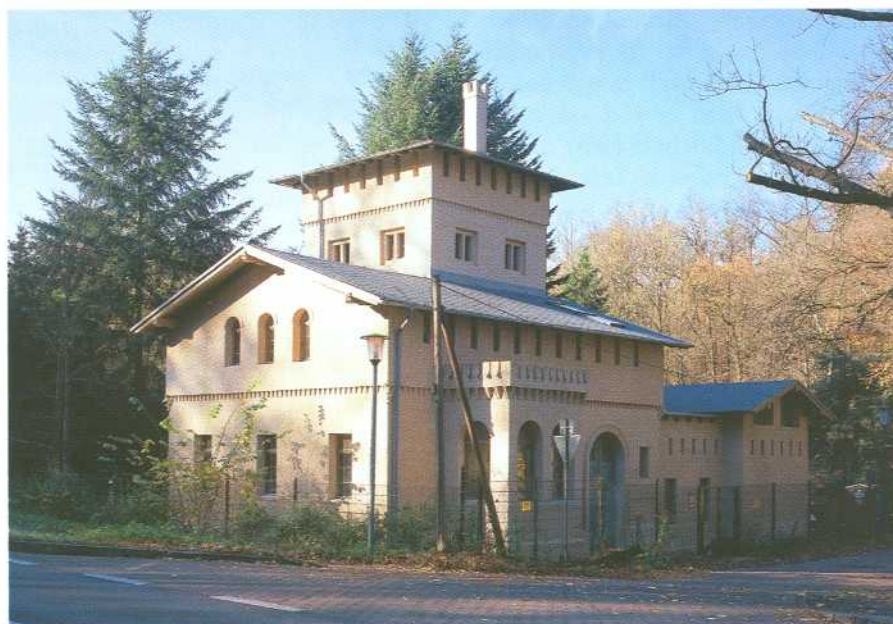
Das Förster-Etablissement am Südtor im Wildpark – ein von Ludwig Persius entworfener Bau in Ziegelbauweise – Ansicht nach der Restaurierung. Foto: Hans Bach, 2006
