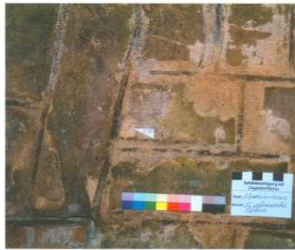
Maschinenhaus im Babelsberger Park, Detail der Umfassungsmauer.
