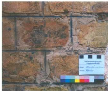
Maschinenhaus im Babelsberger Park, Detail am Sockel.
